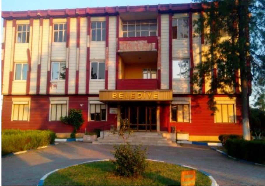
Foto 7. Huzurkent Eski Belediye Binası
