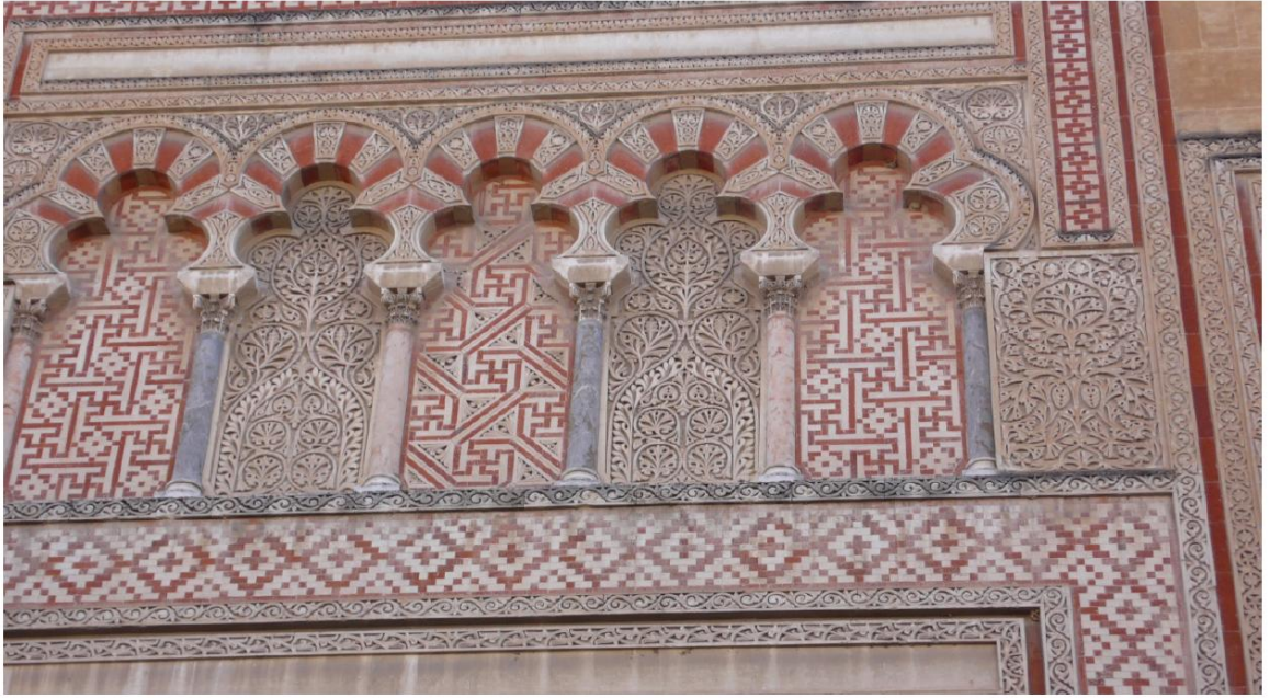
Kurtuba Camii dış duvar süslemelerinden bir görüntü (Yıldız, 2008, s. 240).
