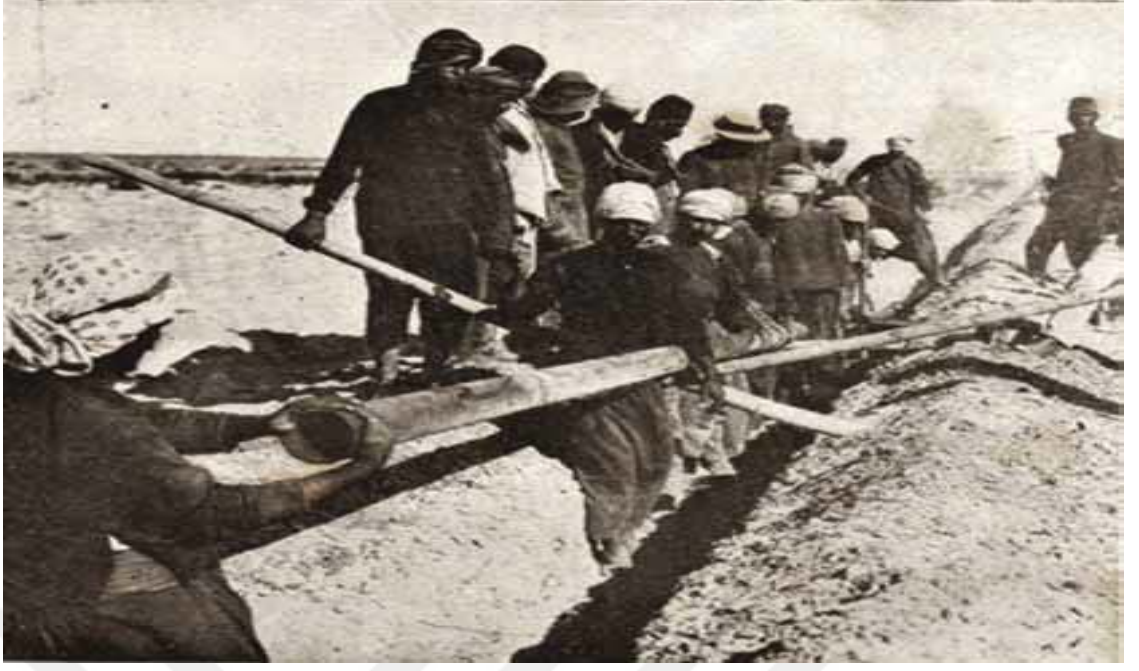
Harp Mecmuası: Mısır Yolunda Su Boruları Döşeniyor Sayı 9, Yıl I, Mayıs 1915, s.133
