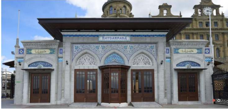
Şekil 13. Haydarpaşa Vapur İskelesi (Aksan, 2014)
