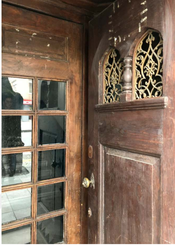
Foto 17 : Giriş kapısı (Tuba Gökçen Kahraman, 2018)
