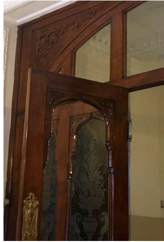
Foto 16: Giriş holü kapı detayı (Tuba Gökçen Kahraman, 2017)
