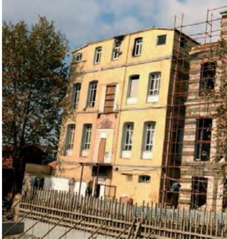
Şekil A. 2: İstanbul Üniversitesi MSB A Blok Binası dış görünüş
