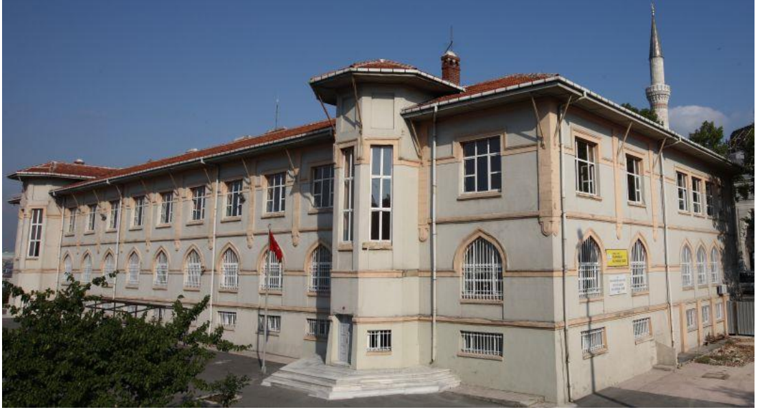
Şekil A. 5: Sultan Selim Kız Meslek Lisesi dış görünüş
