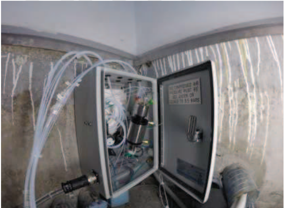
Şekil 7.4. sentez ve siklotron bölümleri arası ortak hat bağlantı kutusu
