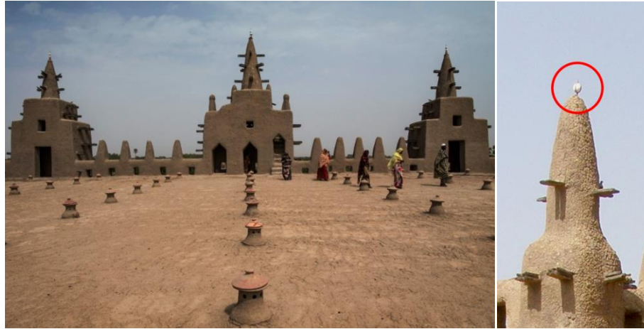
Şekil 4.50. Caminin çatısı ve devekuşu yumurtası (Djenne Ulu Camisi, 2024)
