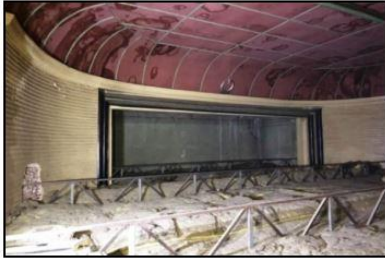
Şekil 3.9. Dilan Sineması İç Mekân
