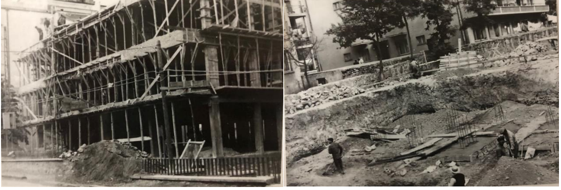
Şekil 4.12. Kavaklıdere Sineması İnşaata.
