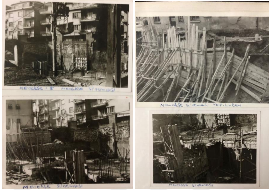
Şekil 3.53. Menekşe Sineması İnşaat Aşaması
