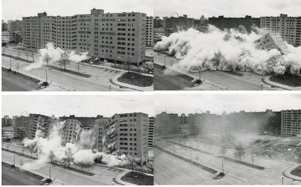
Şekil 2.1. Pruitt-Igoe Konut Kompleksinin Yıkımı (1972)
