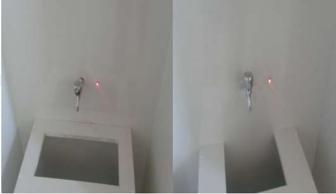
Şekil 4.27. Sıcak su geri dönüşüm sisteminde su ısınıyorken musluk kırmızı led uyarısı
