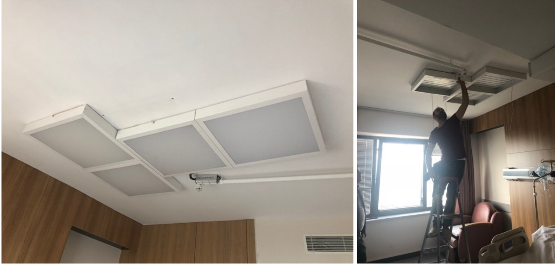
Şekil 42. Aydınlatma montajı (Yazarın Arşivinden)
