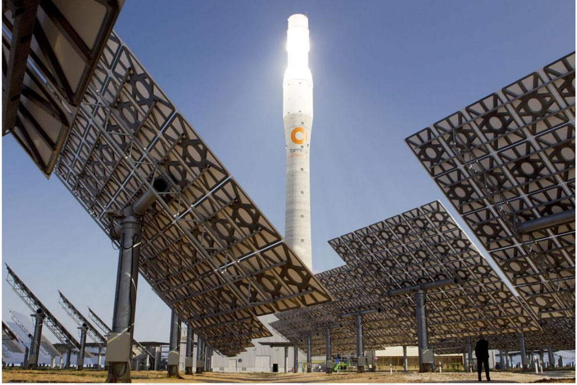
Şekil 3.9. Merkezi Alıcılı Güneş Kolektör Sistemleri (Anonim 2021e)
