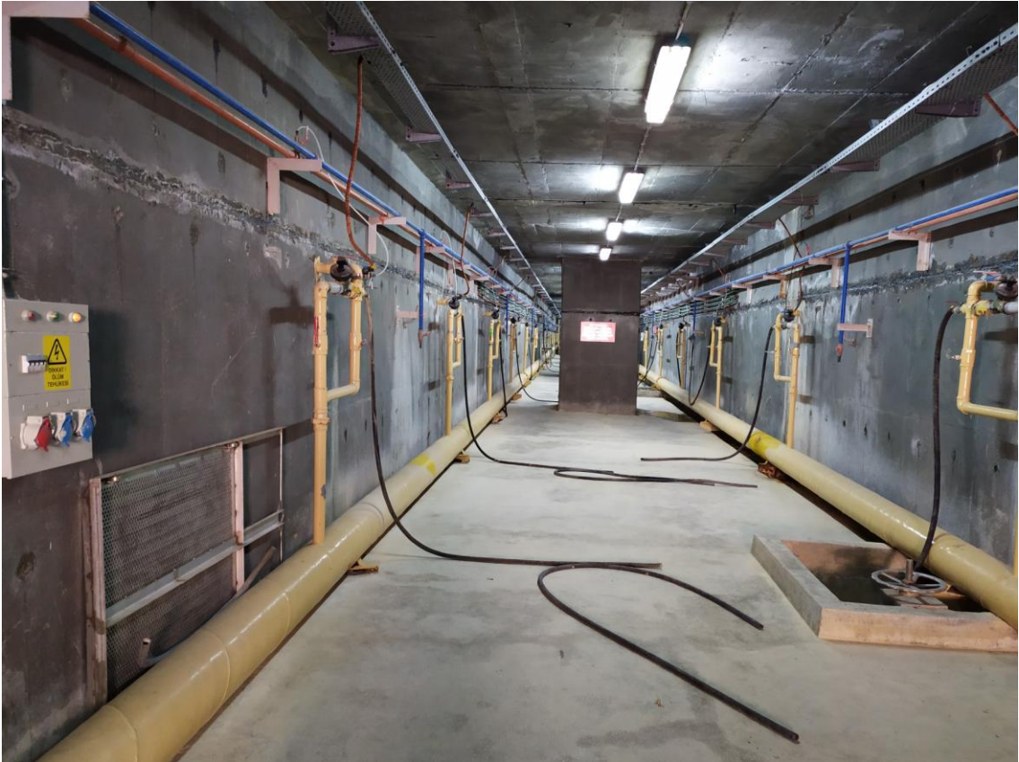
Şekil 3.3. Durultucu havuzları çamur tahliye vanaları.
