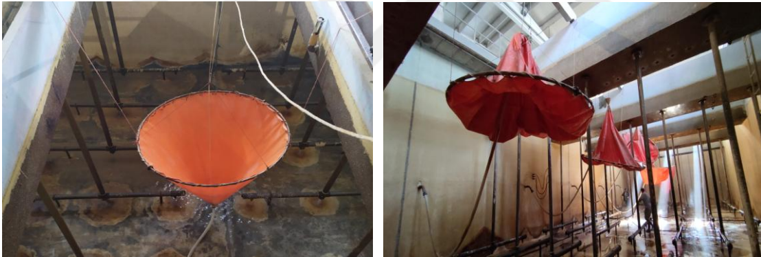
Şekil 3.1. Durultucu havuzları çökeltme konileri.
