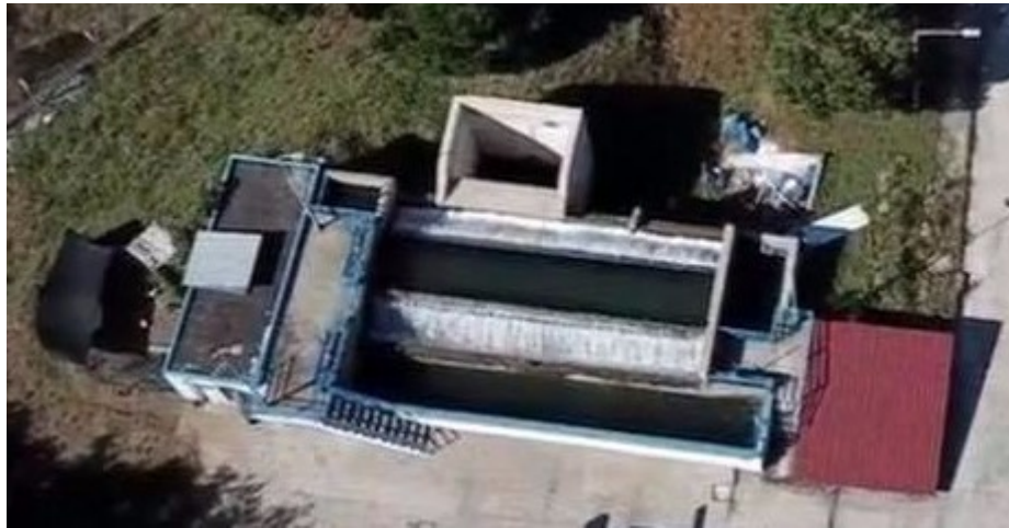
Şekil 3.6: Giriş ve havalandırma yapısı
