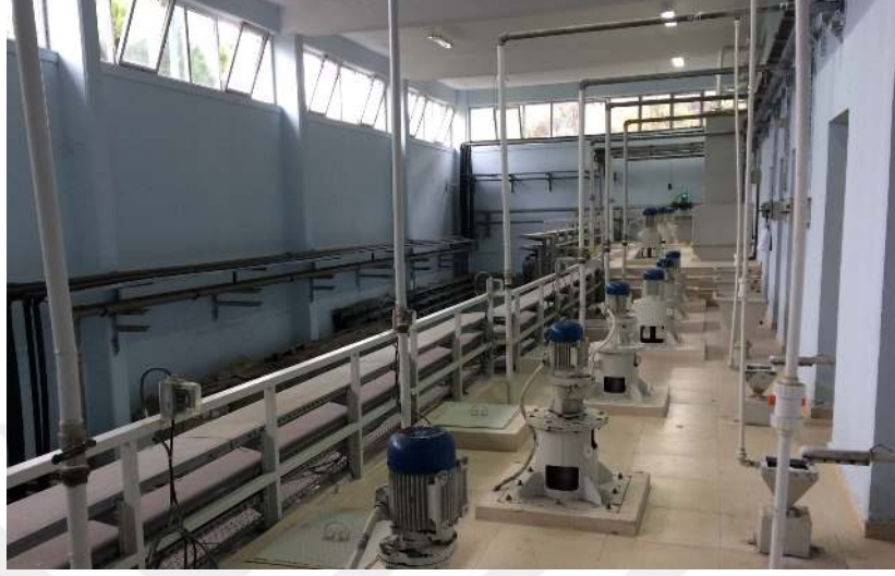
Şekil 3.10: Kimyasal depolama ve dozlama ünitesi
