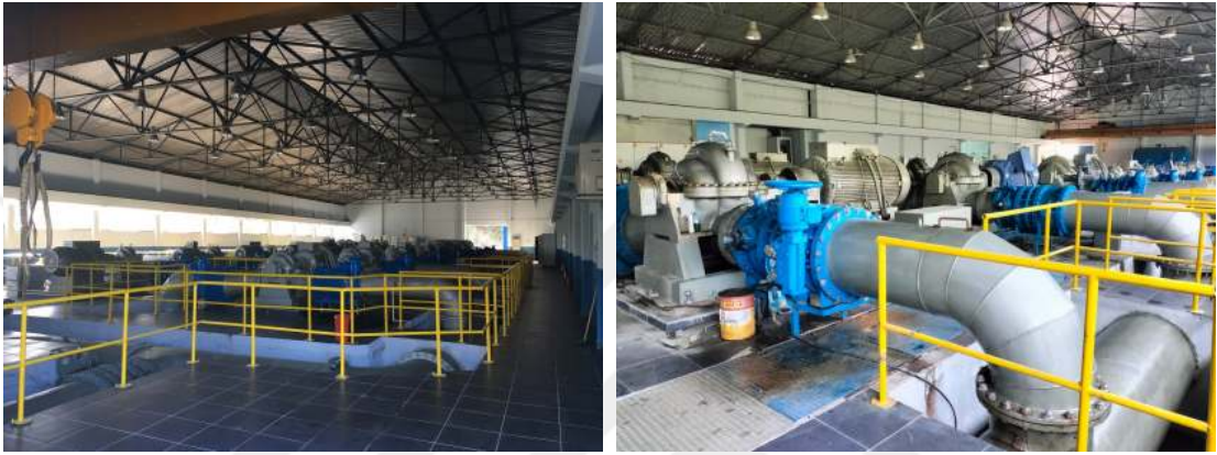
Şekil 3.4: Ana pompa istasyonu motorlar
