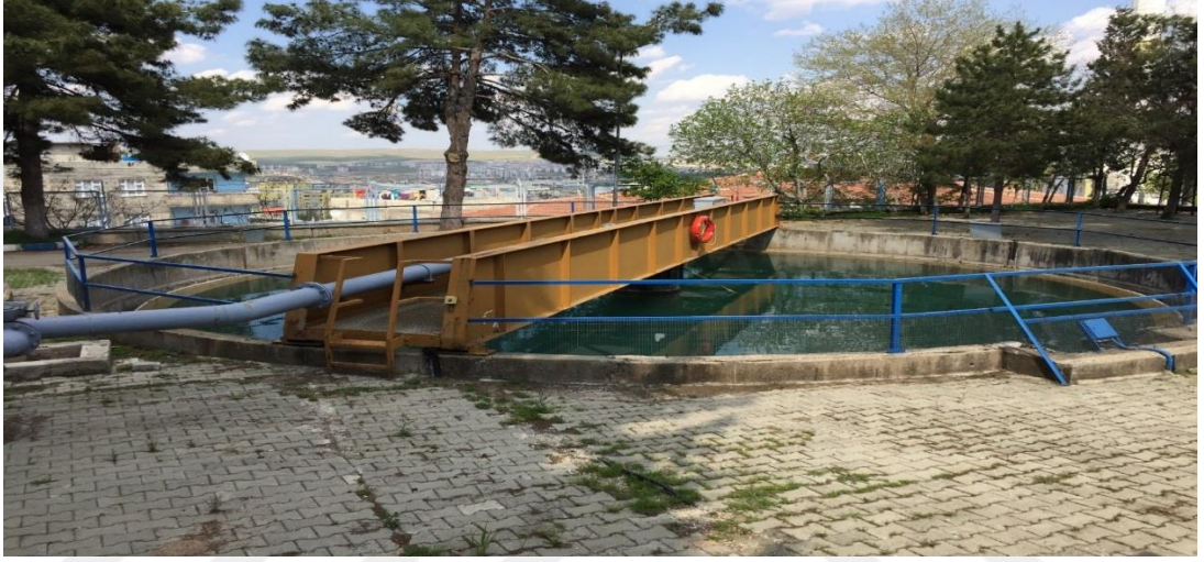
Şekil 3.11: Geri Yıkama Havuzu - 1
