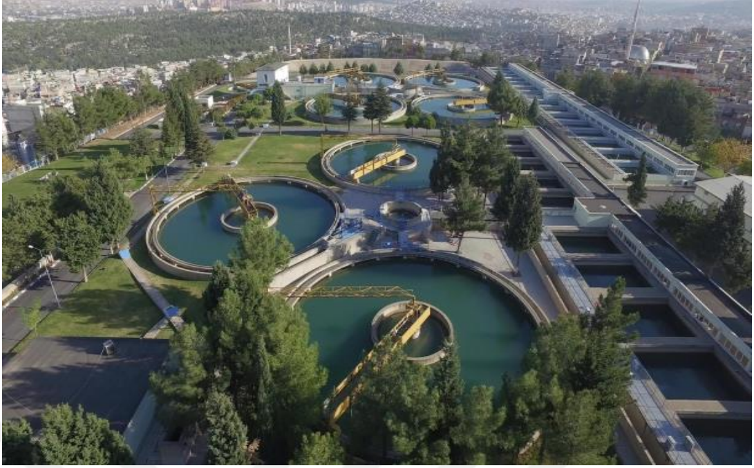
Şekil 3.3: GASKİ Hacıbaba İçme Suyu Arıtma Tesisi (GASKİ, 2019 Performans Programı)
