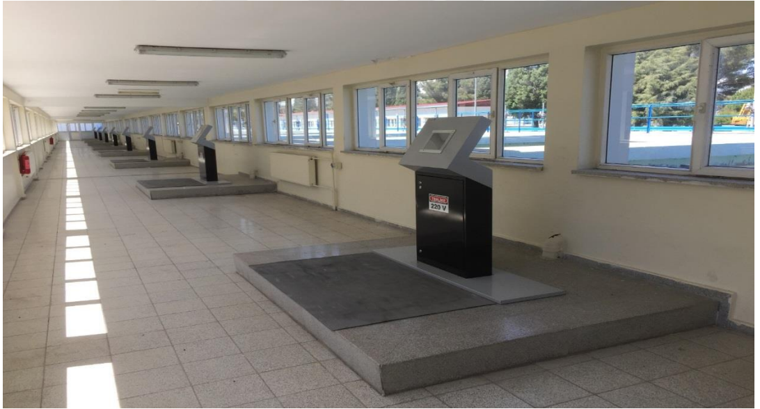
Şekil 3.8: Filtrasyon Ünitesi Kontrol Merkezi
