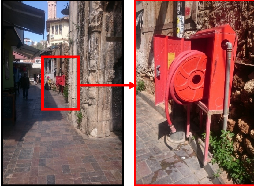
Şekil 4.1. Yangın musluklarının izinsiz kullanımına dair izler
