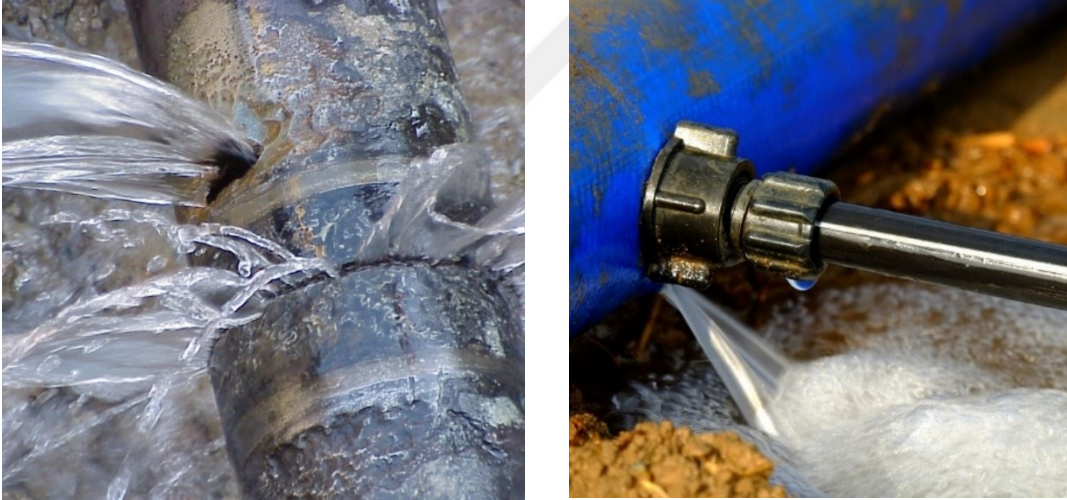
Şekil 2.4. Servis bağlantıları ile abone arasında meydana gelen kayıplar (Anonim – 4, Anonim – 5)
