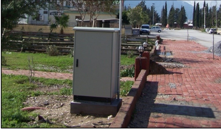
a) Dıştan görünüm
