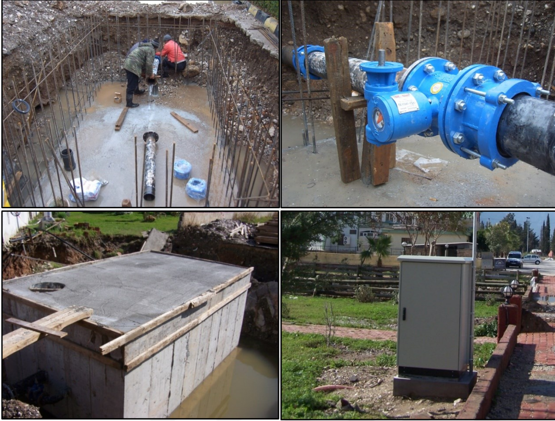
Şekil 3.4. SCADA ölçüm noktasının altyapısı (Kara vd 2016)
