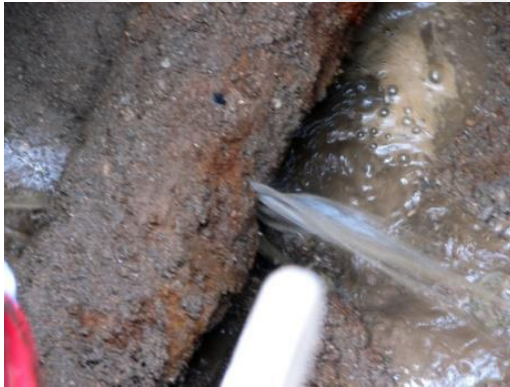
Şekil 2.10. Borulardan oluşan sızıntı, hidrolik olarak orifis deşarjına benzer (Muhammetoğlu ve Muhammetoğlu 2017)
