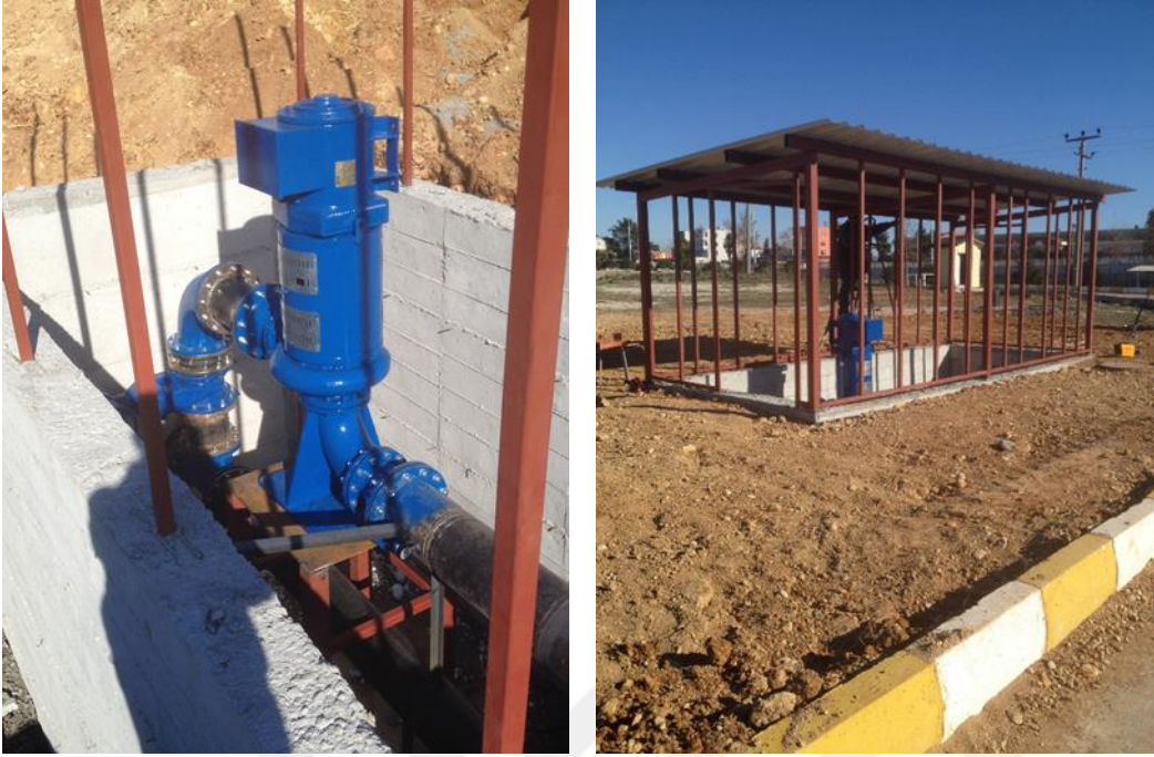
Şekil 3.13. Bypass rögarı üzerine kabin yapılması (Muhammetoğlu vd. 2016)
