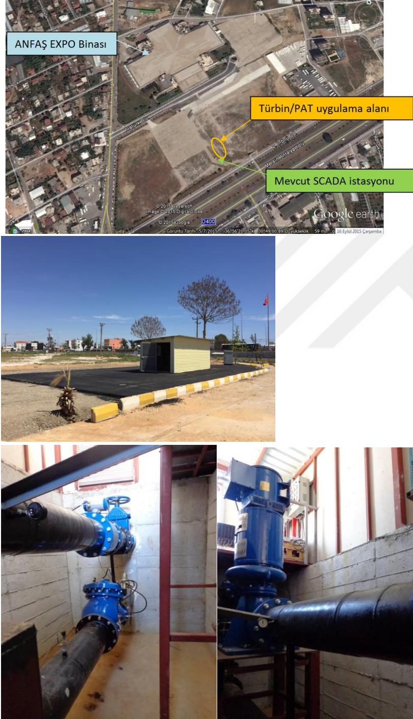
Şekil 2.18. Antalya Anfaş bölgesinde kurulan PAT sistemine ait görüntüler (Muhammetoğlu vd. 2017a)
