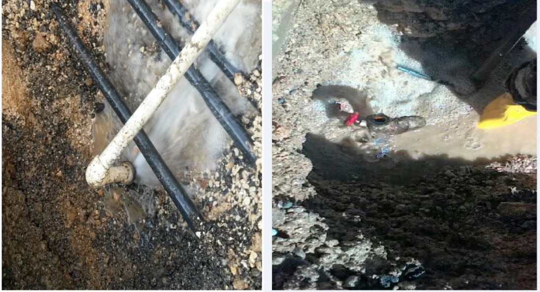
Şekil 7.14 Sızıntı Noktalarına ait Görüntüler (MASKİ, 2017)
