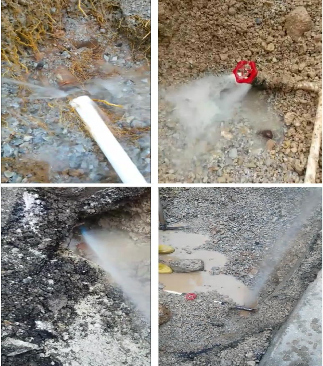
Şekil 7.5 Sahada Sızıntı Tespiti Çalışmaları (MASKİ, 2017)
