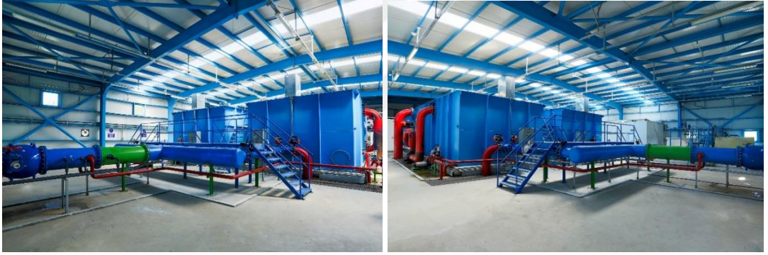
Şekil 2.1. Hacımercan İçmesuyu Arıtma Tesisi.
