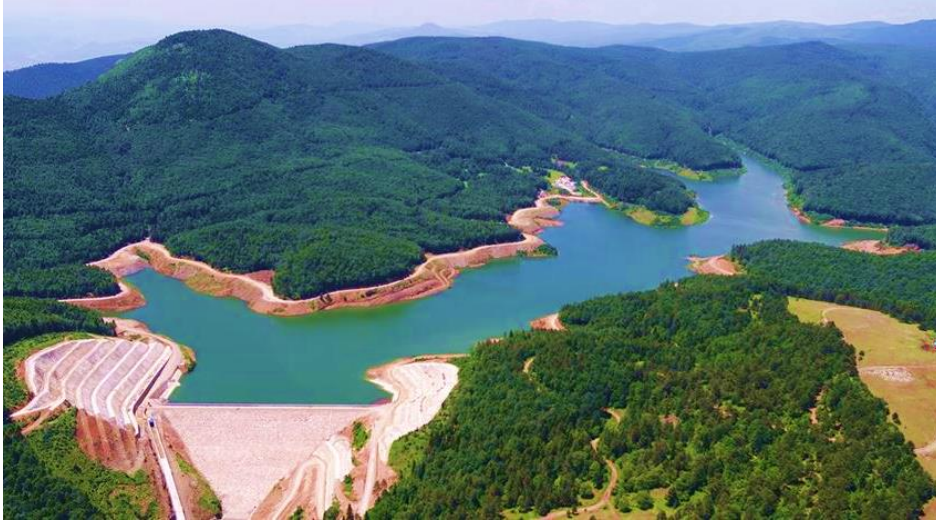
Şekil 2.2. Akçay Barajı kuşbakışı görünüm.
