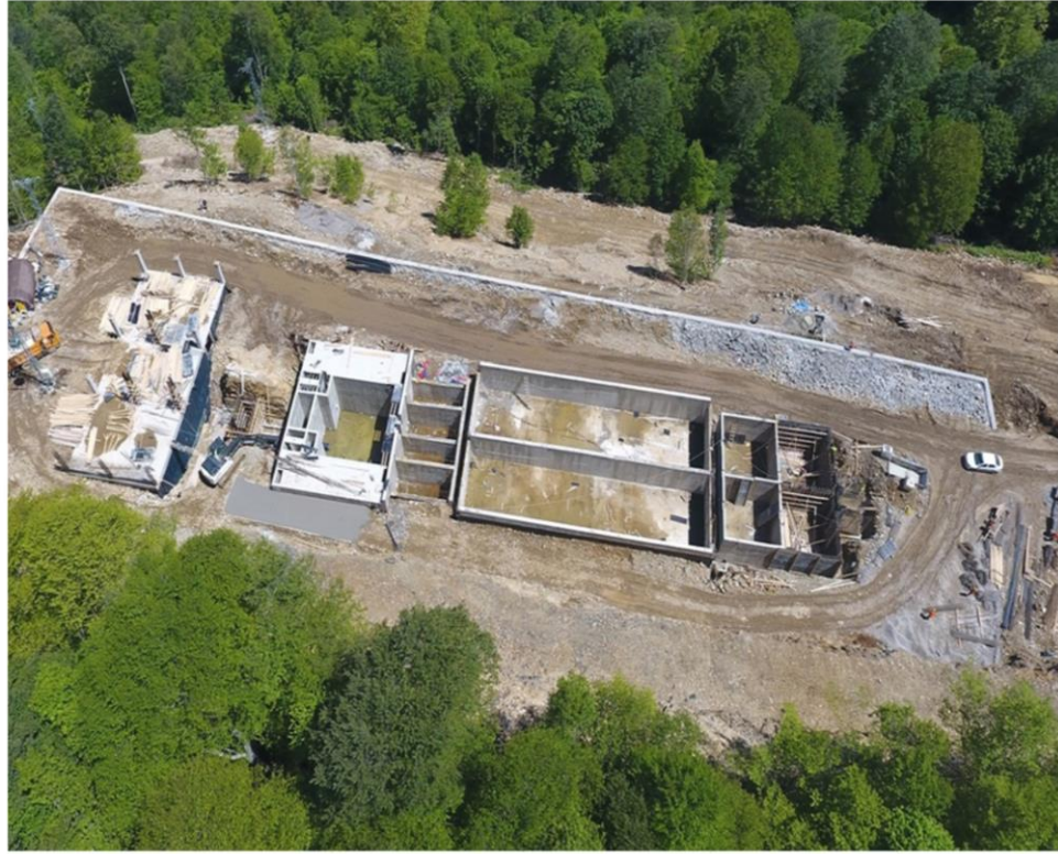
Şekil 2. Ordu Gölköy İ.A.T inşaat çalışmaları
