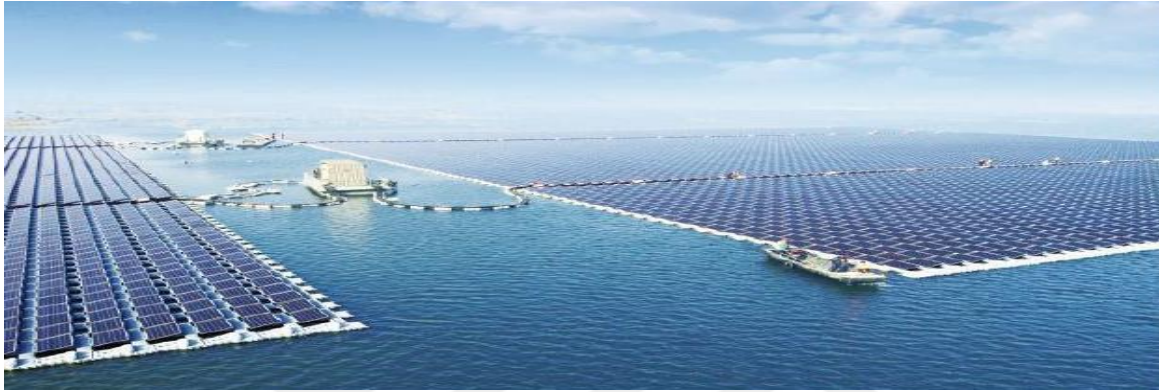
Resim 2.11. Solar evirici ve elektrik ekipmanlarının yüzdürüldüğü sistem
