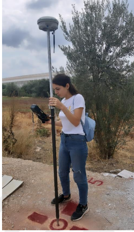
Şekil 3.8. Çalışma sahasında YKN'lerin ölçülmesi
