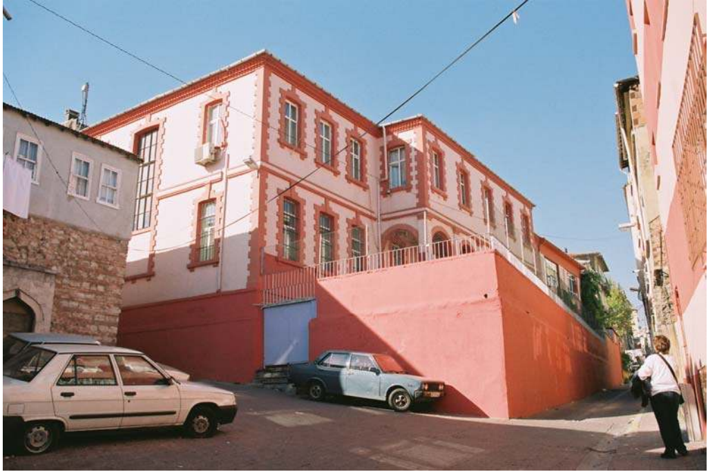
Fotoğraf No 80: Kasımpaşa (Bahriye)Askeri Rüşdiyesi'nin Güney batı Cephesi
