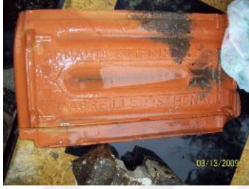
Şekil 5.19: Bursa İpekçilik Mektebi'nin çatısında kullanılan marsilya kiremidi (YBA arşivi).
