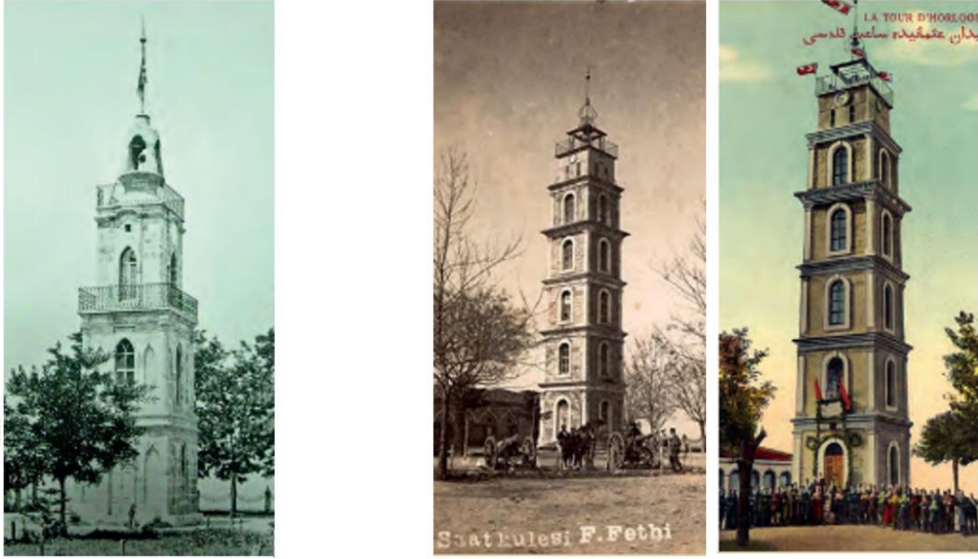
Şekil 3.5: Abdülaziz döneminde yapılan Tophane Saat Kulesi (1861-1876) (sol fotoğraf)-1904-1905 yıllarında yapılan Tophane Saat Kulesi (Sağ Fotoğraflar) (Sarıbaş, 2019).
