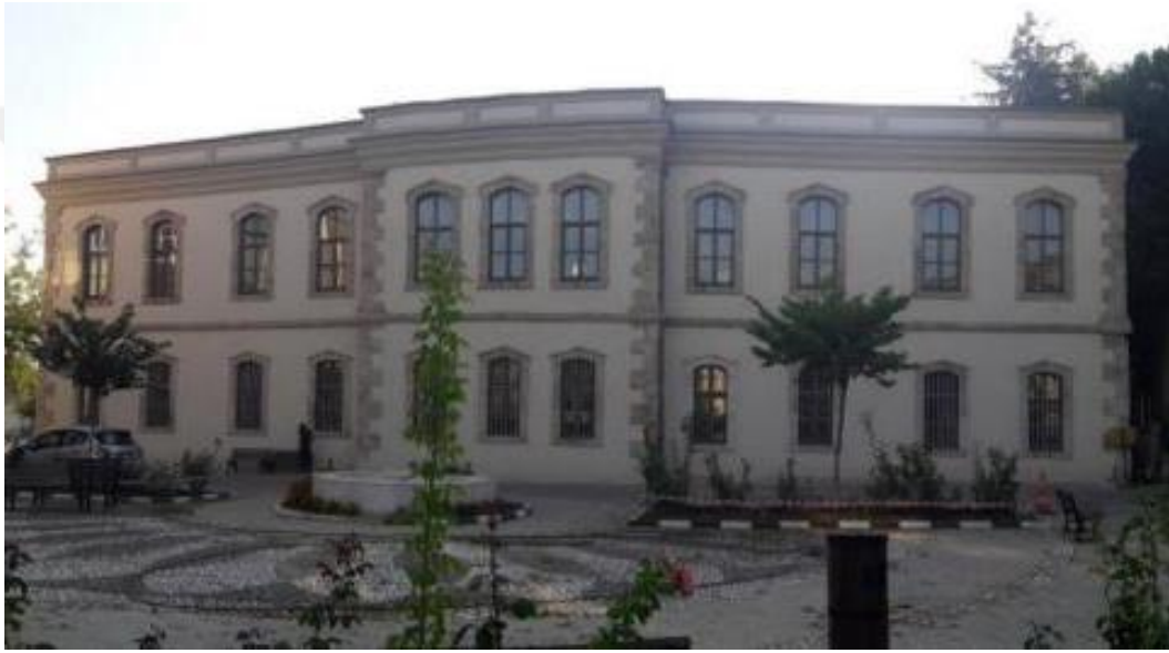
Şekil 4.64: Bursa Erkek Lisesi'nin yan cephesi (doğu).
