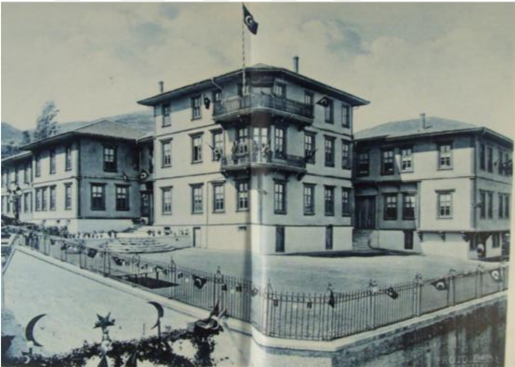
Şekil 4.79: Hamîdiye Medrese-i Muallimin-Güney-Doğu Cephesi (HVS, H.1325).
