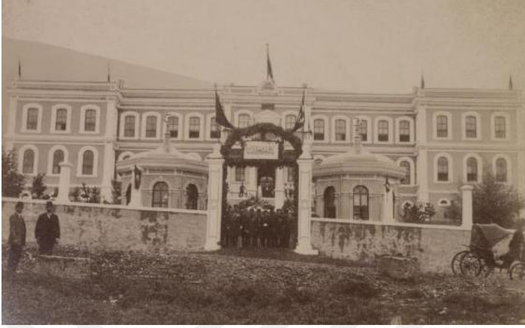
Şekil 4.20: Bursa Mekteb-i Fünûn-u İdâdîsi'nin ana bina ön cephe (İNK arşivi, Nr. 90852-40).
