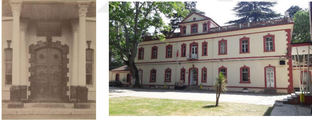
Şekil 4.15: Ziraat Mektebi'nin giriş bölümü (İNK arşivi, Nr. 90852-27) (sol fotoğraf) ve Ana bina'nın arka görünümü (sağ fotoğraf).
