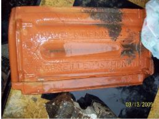
Şekil 4.52: Bursa İpekçilik Mektebi'nin yapının çatısında kullanılan marsilya kiremidi (YBA arşivi).
