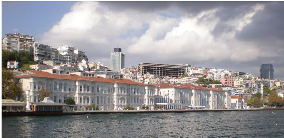
Resim 119: Sanayi-i Nefise Mektebi Âlisi Binası.
