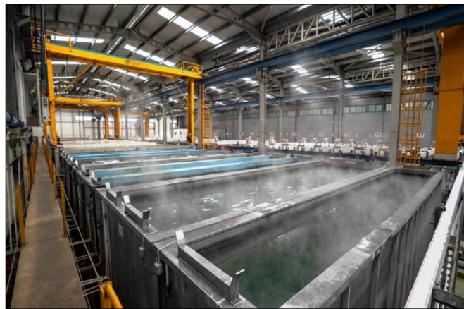
Şekil 4.2. Eloksal kaplama havuzları görünümü(Çoruhlu, 2023).
