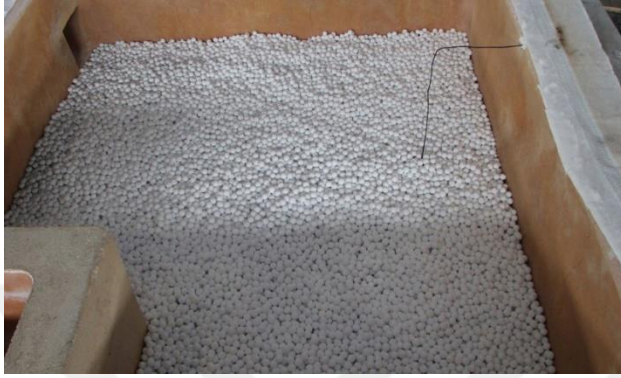
Şekil 2.19. Derin Yatak Filtreleme Ünitesi (DBF) ve içerisinde bulunan alümina topraklar [36].
