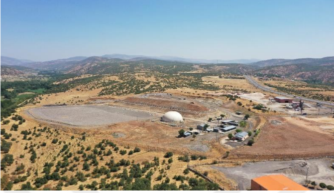
Şekil 5.4. Bingöl Katı Atık Düzenli Depolama Tesisi
