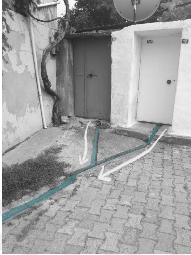
Şekil 7.5 Atıksu ve yağmur olukları ilişkisi (Kaynak: (Kaynak: Arazi tespitleri, Eylül 2022)
