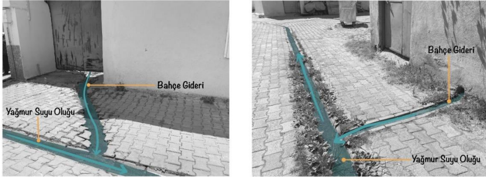
Şekil 7.15 Yapı girişleri ve kanal/oluk ilişkisi örnekleri – II (Kaynak: Arazi tespitleri, Haziran 2023)
