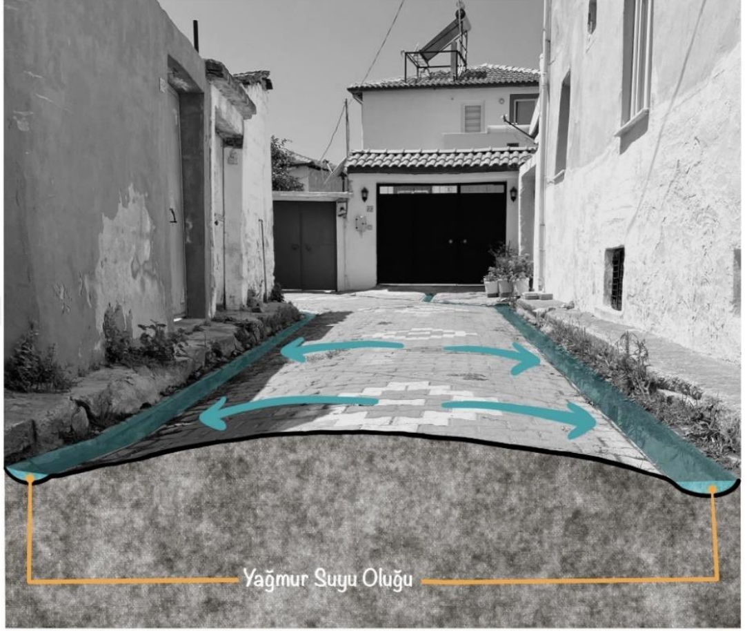
Şekil 7.10 Dışbükey sokak tipolojisinde yağmur suyu oluğu (Kaynak: Arazi tespitleri, Haziran 2023)
