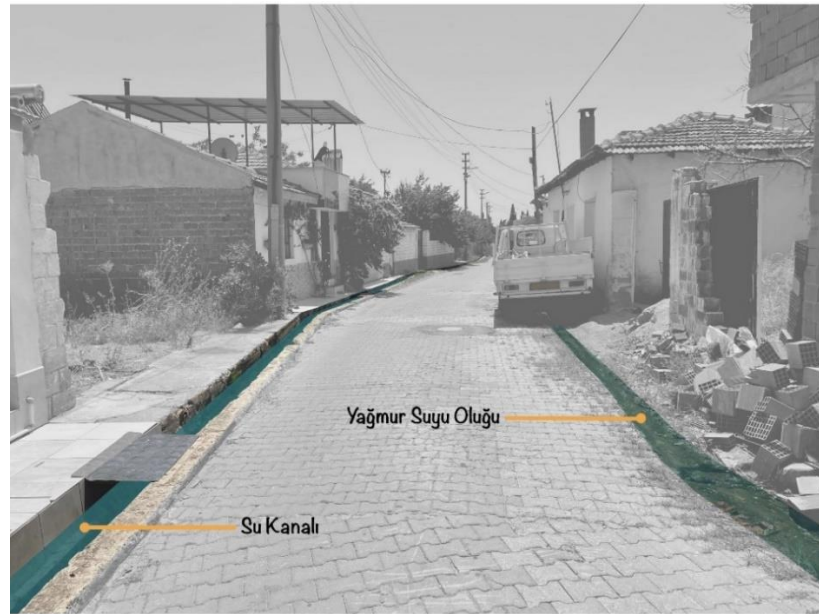
Şekil 7.3 Su kanalı ve yağmur suyu oluğu örnekleri (Kaynak: Arazi tespitleri, Haziran 2023)
