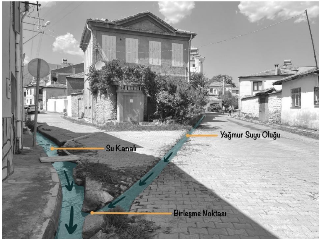
Şekil 7.4 Su kanalı ve yağmur suyu oluğu ilişkisi (Kaynak: Arazi tespitleri, Haziran 2023)
