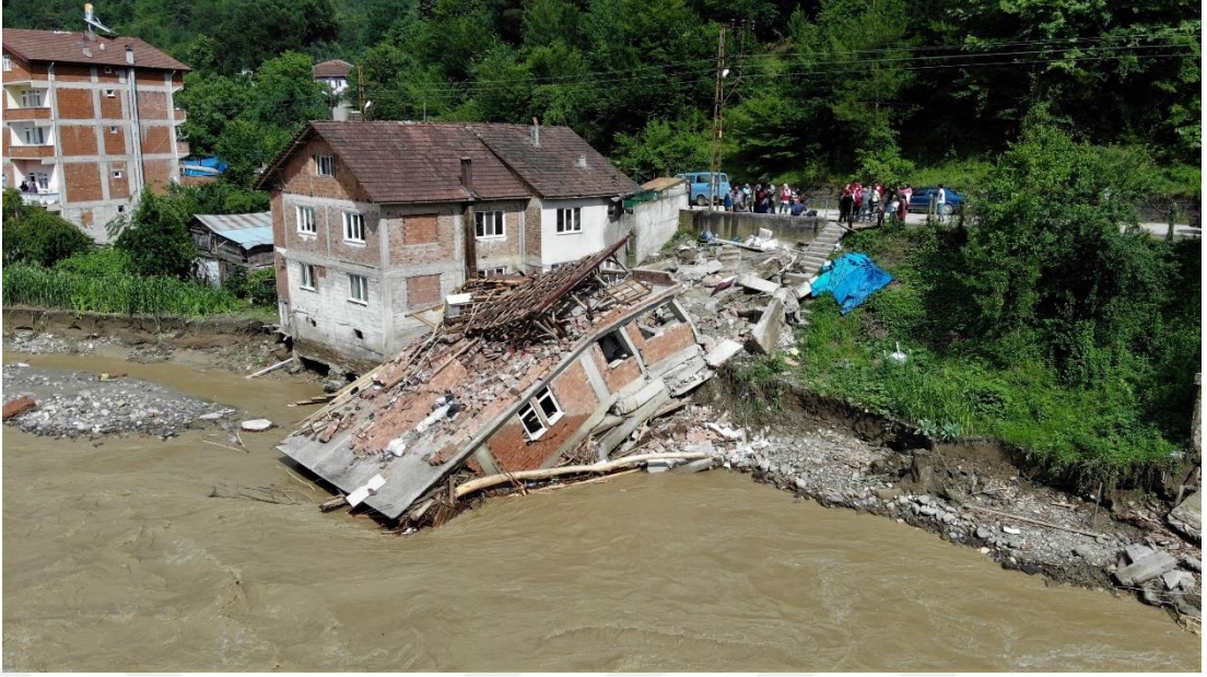
Şekil 4.3: Türkiye'nin kuzeyindeki Karabük'te sel nedeniyle evler çöktü, 29 Haziran 2022 (Kaynak: Url-8).
