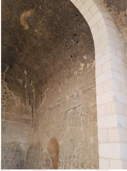
Şekil 4.82. Şubat 2020'de Küçük Saray'ın Batı Cephe Duvarı ve Beşik Tonoz Örtüsü
