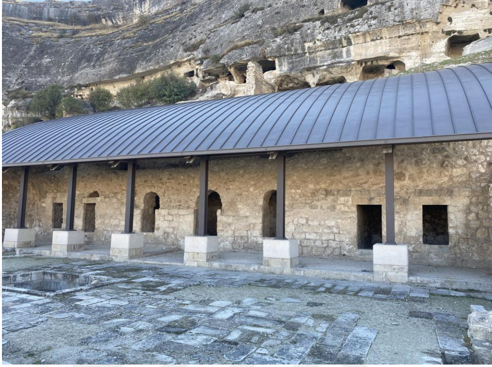
Şekil 4.53. 2021 Kasım Ayında Yamaç Külliyesi Genel Görünüm.
