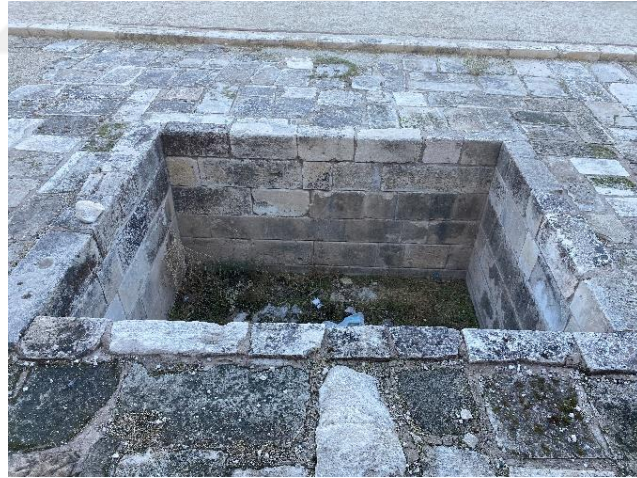
Şekil 4.65. Kasım 2021'de Avluda Yer Alan Havuz.
