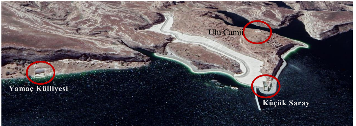
Şekil 4.49. Hasankeyf'te Belirlenen Yapıların Ilisu Baraj Göleti İle Olan İlişkisi. Kaynak: Görsel Google Earth Üzerinden Alınmıştır.
