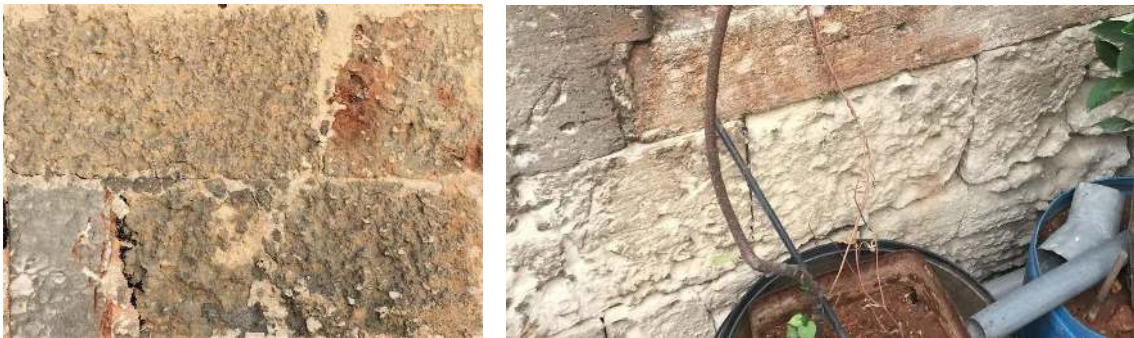
Şekil 3.5. Oyuklanma Görülen Taş Örnekleri.
