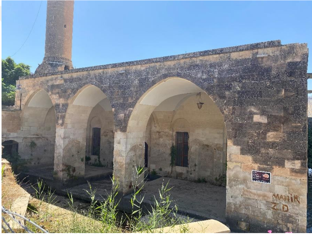
Şekil 4.24. 2022 Yılında Halfeti Ulu Camii'nin Kuzey Cephesi.
