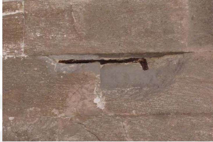
Şekil 3.4. Para Kopması (Görün Arun arşivinden).
