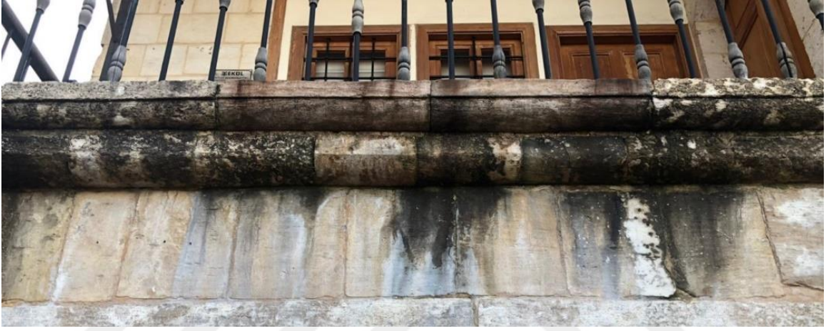
Şekil 3.9. Metin Sözen Eğitim ve Kültür Merkezi'nin Cephesinde Kabuk Oluşumu.
