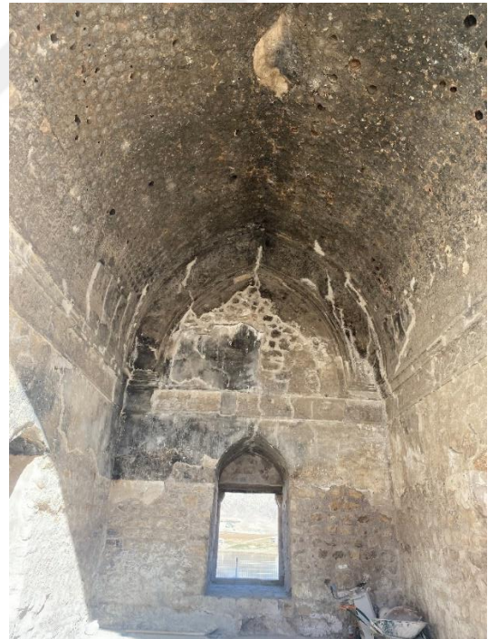
Şekil 4.81. Kasım 2021’de Küçük Saray’ın Beşik Tonz Örtüsü.
