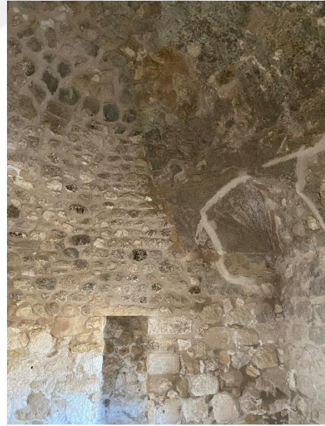
Şekil 4.59. Kasım 2021'de Batı Zaviye Bölümü.
