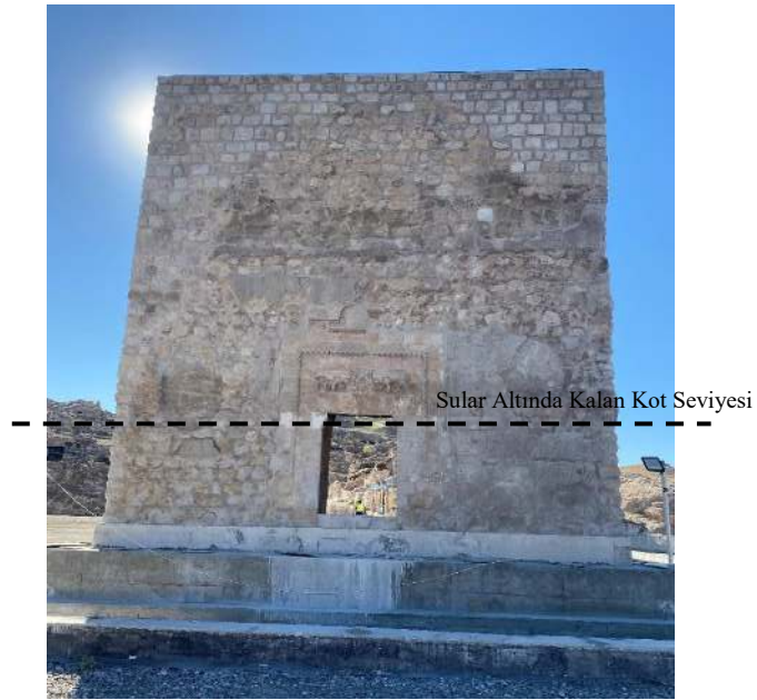
Şekil 4.73. Kasım 2021’de Küçük Saray’ın Kuzey Cephesi
