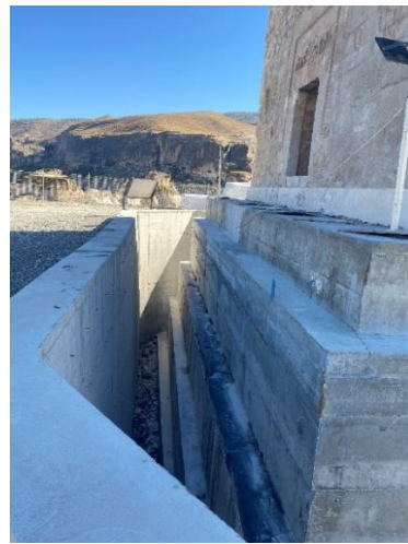
Şekil 4.71. Kotu Betonarme Temelle Yükselen Küçük Saray.
