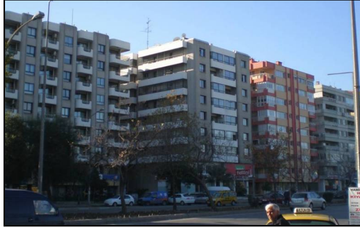
Şekil 4.17 Örnek yapının kuzey cephesinden görünüm
