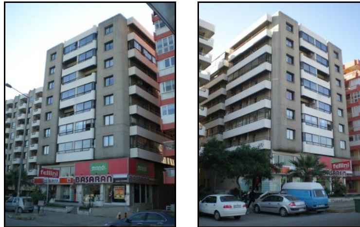
Şekil 4.19 Örnek yapının batı ve doğu cephelerinden görünüm
