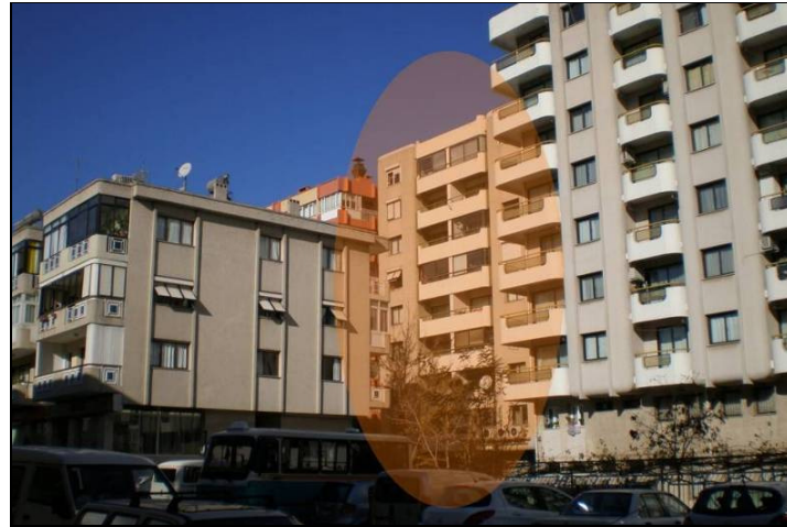
Şekil 4.18 Örnek yapının güney cephesinden görünüm
