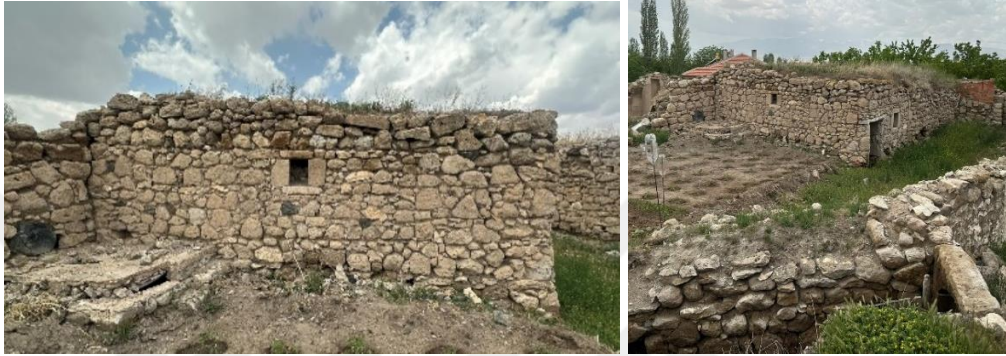
Şekil 5. 48. Yeşilova köyünde incelenen 4 numaralı evin doğu cephesi ve çevresi
