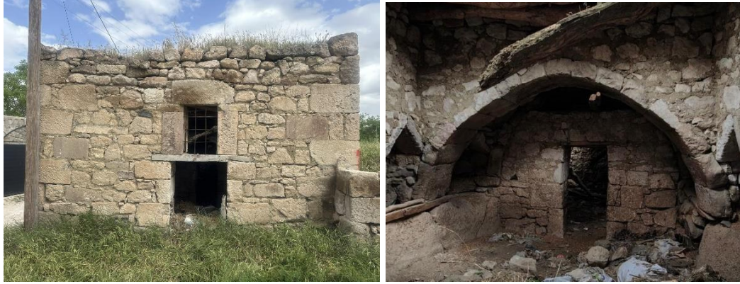
Şekil 5.75. Uluğaç köyünde incelenen 5 numaralı evin doğu cephesi ve iç mekânı
