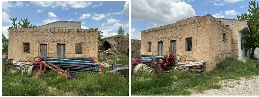
Şekil 5.46. Yeşilova köyünde incelenen 3 numaralı evin doğu cephesi ve çevresi
