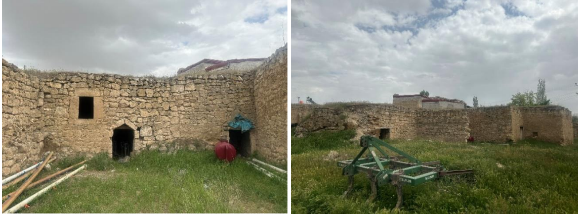
Şekil 5.26. Ovacık köyünde incelenen 4 numaralı evin doğu cephesi ve çevresi
