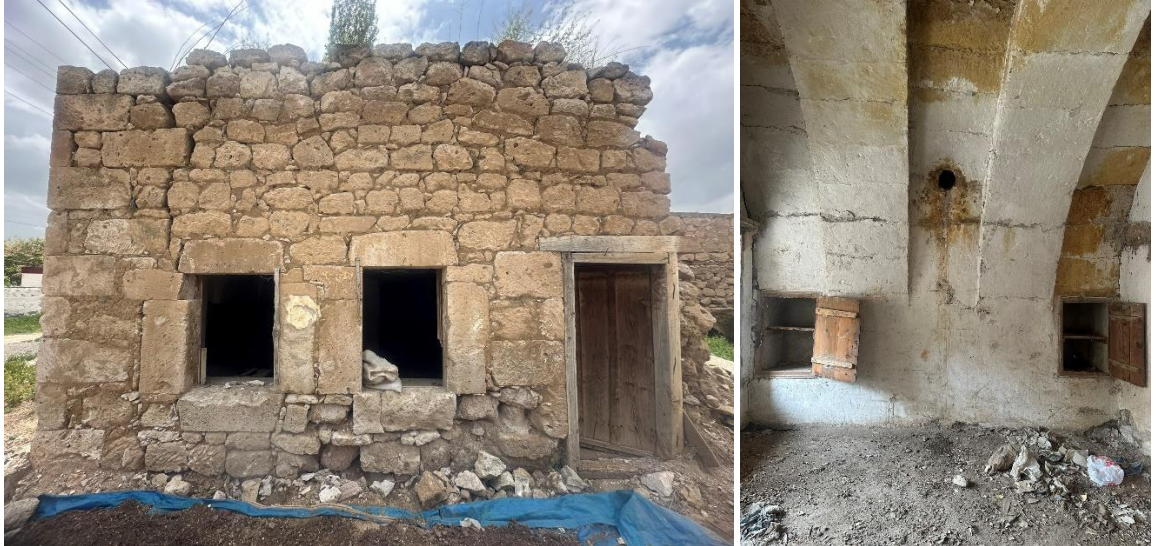
Şekil 5.20. Ovacık köyünde incelenen 1 numaralı evin doğu cephesi ve iç mekânı
