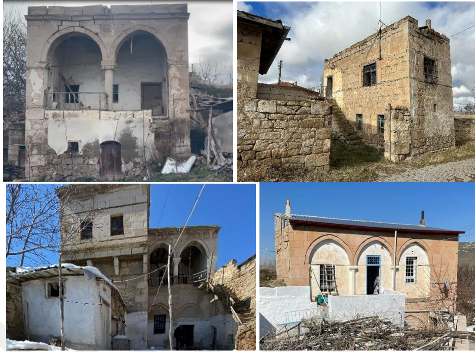
Şekil 5.62. Uluğaç'taki evlerde görülen revaklı bölüm ve merdivenler
