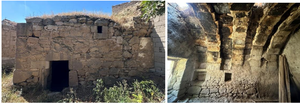
Şekil 5.67. Uluğaç köyünde incelenen 1 numaralı evin doğu cephesi ve iç mekânı
