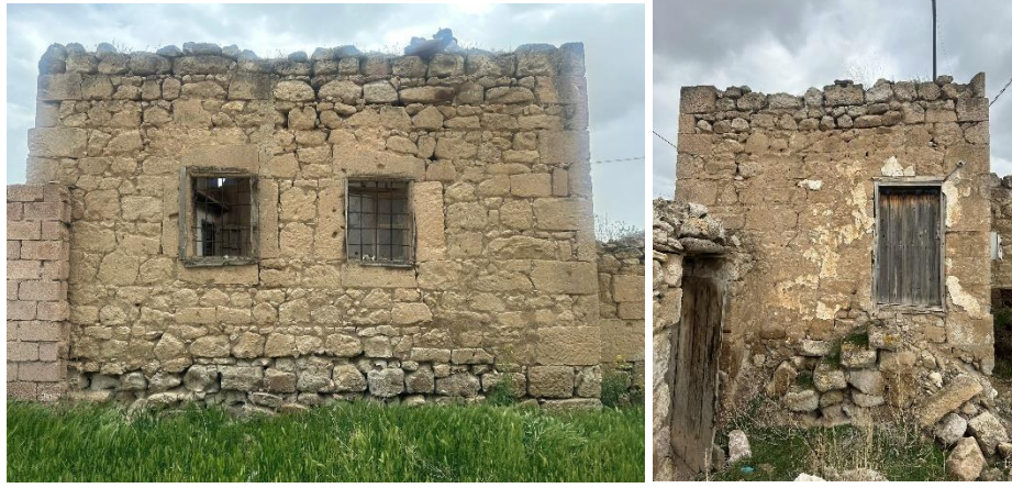
Şekil 5.24. Ovacık köyünde incelenen 3 numaralı evin doğu ve kuzey cephesi
