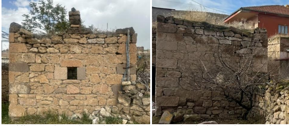
Şekil 5.73. Uluğağ köyünde incelenen 4 numaralı evin doğu ve kuzey cephesi
