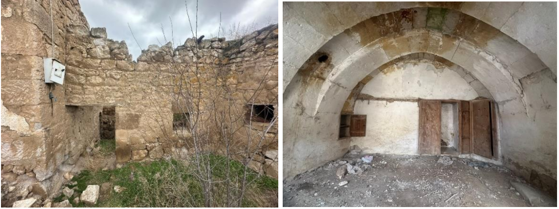
Şekil 5.17. Kayalıkların kullanıldığı temel sistemi ve tonoz sistemi
