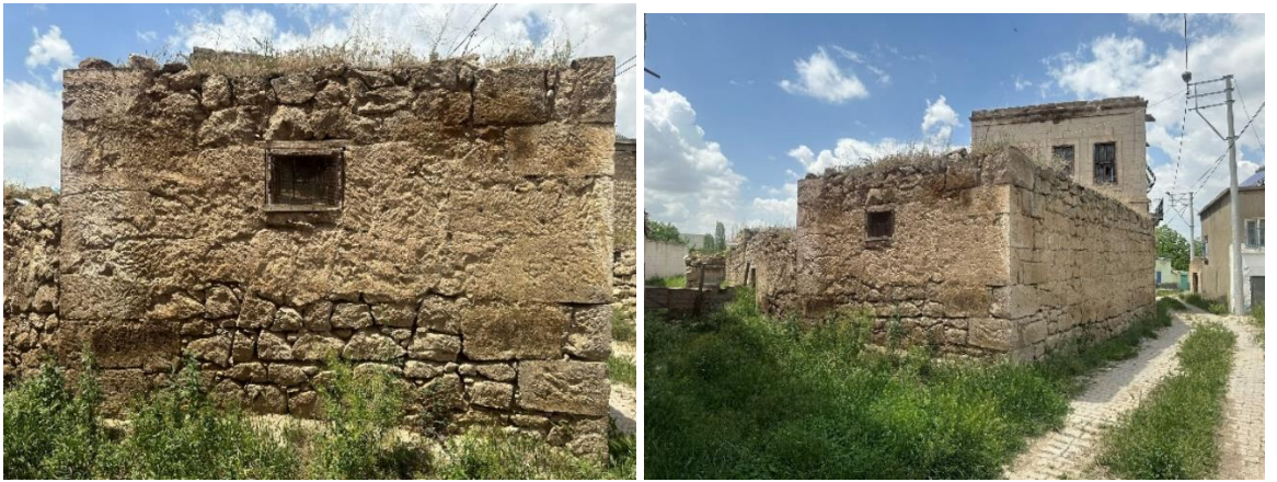
Şekil 5.42. Yeşilova köyünde incelenen 1 numaralı evin doğu cephesi
