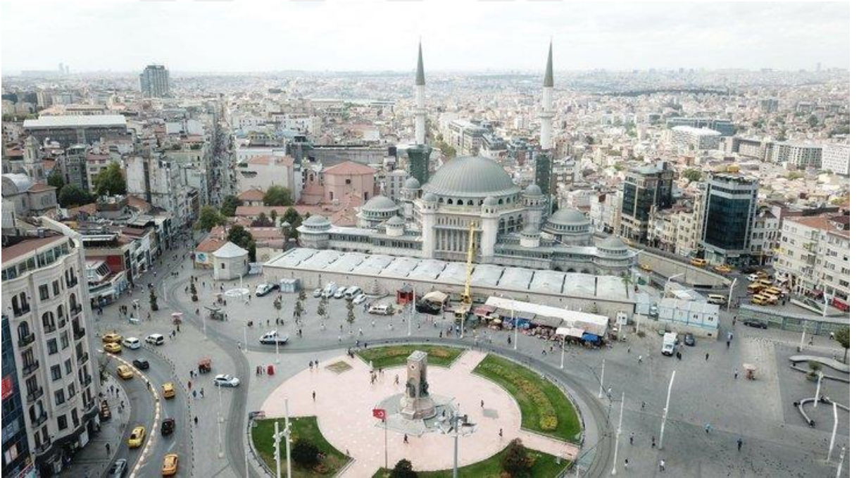
Şekil 26: Taksim Camii İnşaatı
