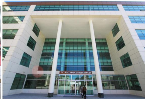
belediye binası girişi
