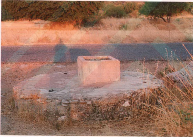
Şekil 4.5.: Camiboğazı Vadisinde Açılan Keson Kuyulardan Bir Görüntü
