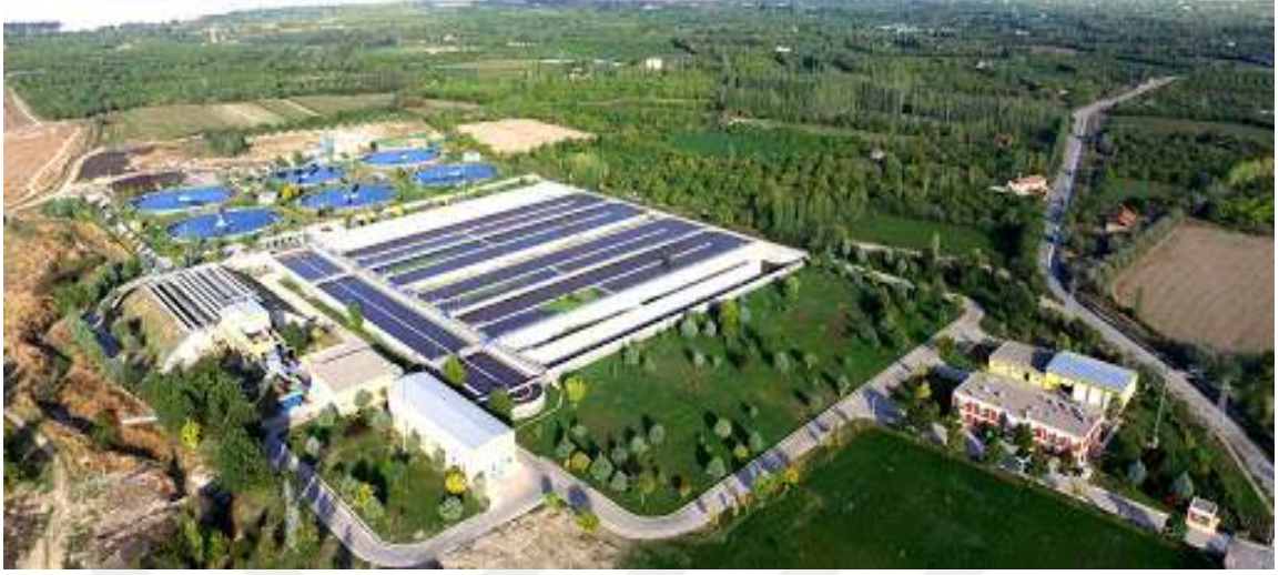
Şekil 3.2. Malatya İleri Biyolojik Atıksu Arıtma Tesisi (MASKİ, 2020)
