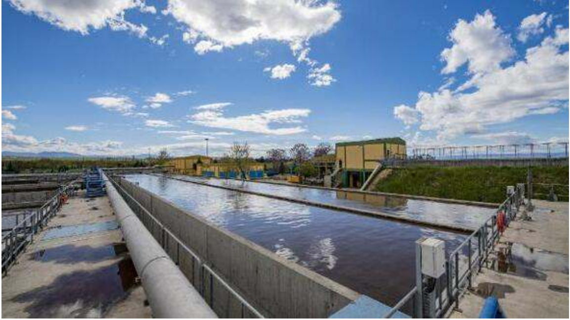
Şekil 3.5. Anaerobik ve Aerobik Havuzlar (MASKİ, 2020)
