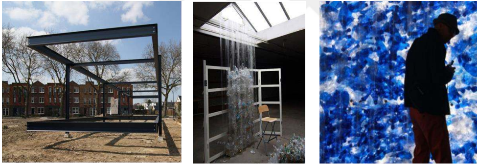
Şekil 5.25. Yapıyı oluşturan çelik konstrüksiyon ve duvarların oluşum aşaması (URL-30)
