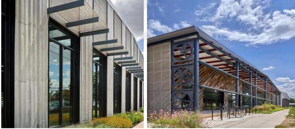
Şekil 5.15. Ofis cephesinde kullanılan metal ve ahşaplar, egzoz fanları (URL-22)
