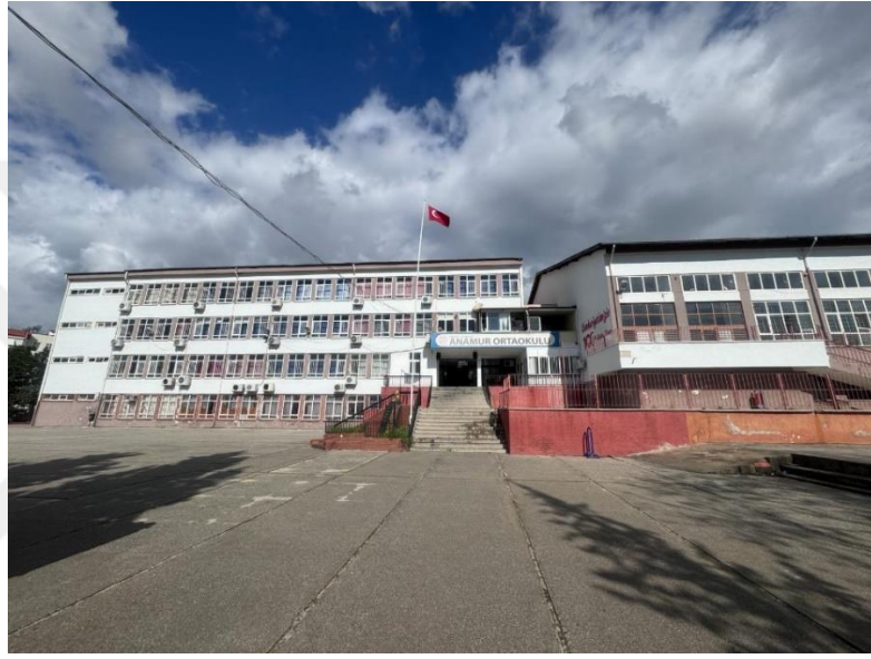
Görsel 3. 1. Uygulamanın yapıldığı Anamur Ortaokulu
