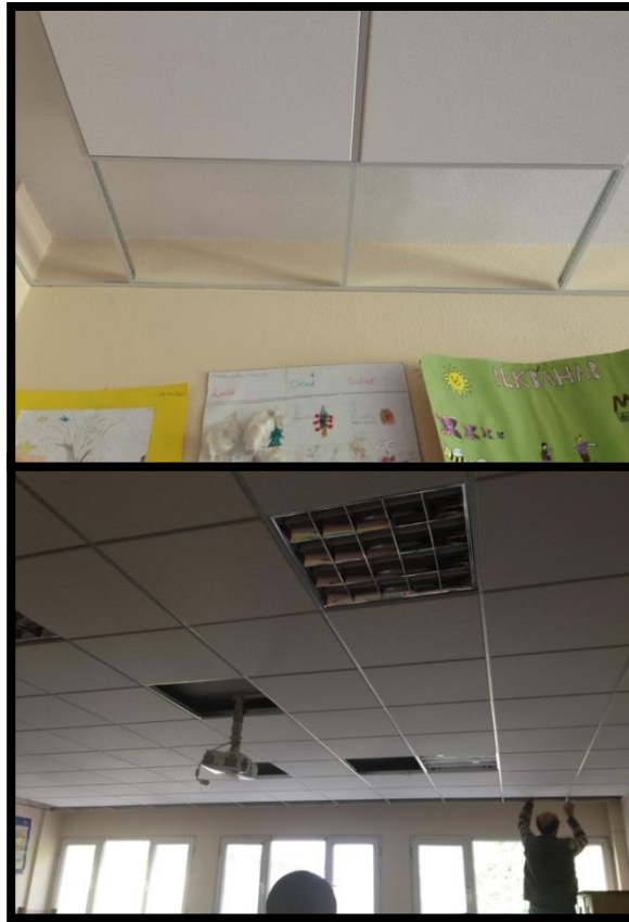
Şekil 4.78 :3B/7B sınıfına birinci iyileştirme kapsamında akustik asma tavan yapılması
