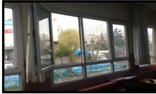
Şekil 4.74 :3B/7B sınıfının mevcut durumunun cephe doğraması.
