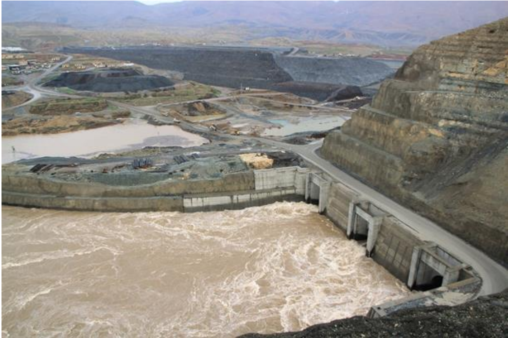
Şekil 3.2. Ilısu Barajı Dipsavak Yapısına dönüştürülen derivasyon tünelleri
