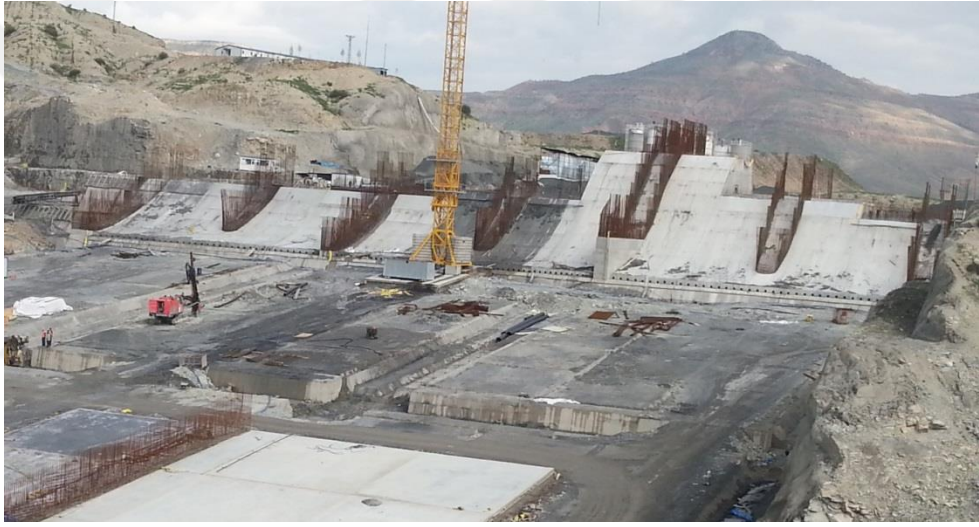
Şekil 3.1. (devam) Ilisu Barajı dolusavak eşik yapısı ve Beton Baraj (Çelen vd. 2013)
