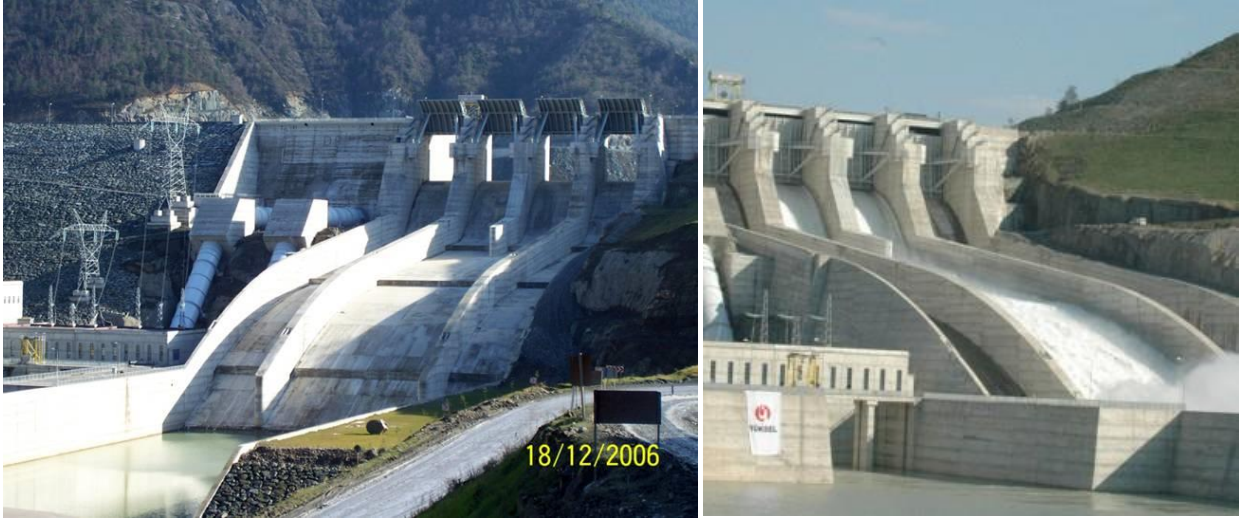
Şekil 2.8. Baca ve saptırıcının birlikte olduğu dolusavak örneği (Borçka Barajı)
