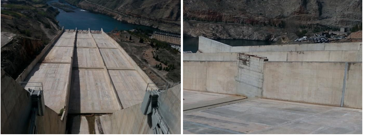
Şekil 2.9. Keban Barajında sonradan yapılan havalandırıcılar
