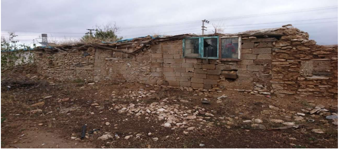
Şekil 4.12: Metruk Bina Örneği -1- (Anonim, 2019)
