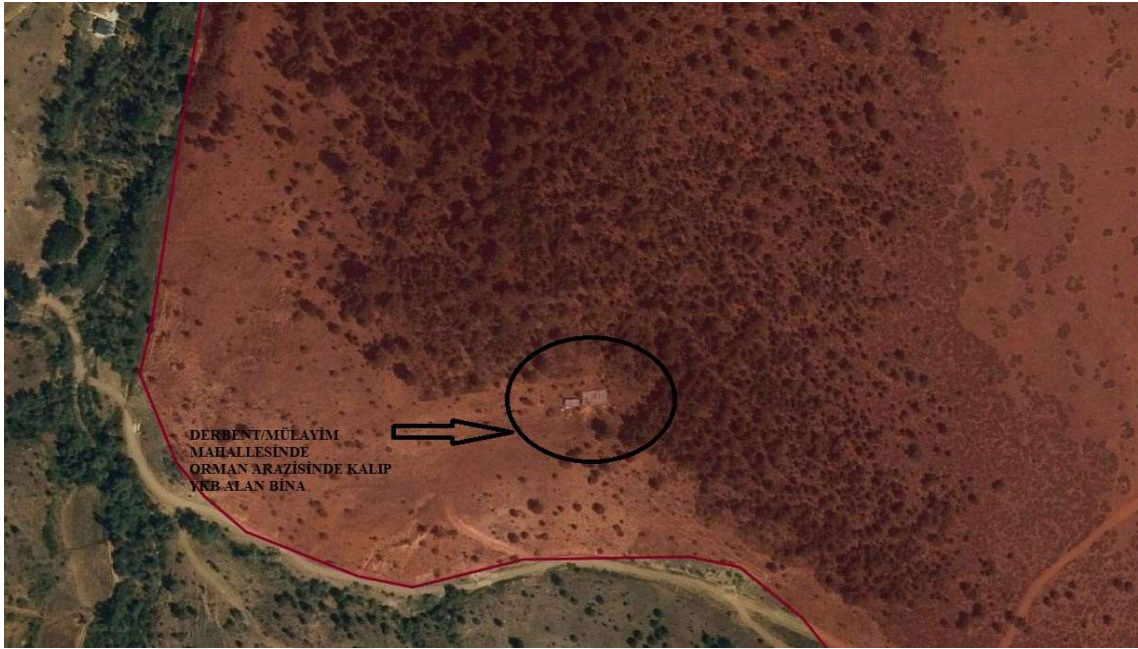
Şekil 4.15: Orman Parselinde Kalan YKB'li Yapı Derbent ilçesi /Mülayim Mahallesi (Anonim, 2019)
