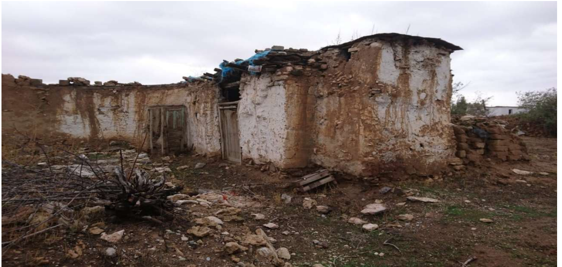
Şekil 4.13: Metruk Bina Örneği -2- (Anonim, 2019)
