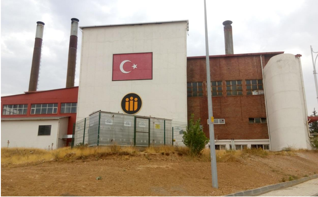
Şekil 3.1: İnönü Üniversitesi Merkezi Isı Santrali.
