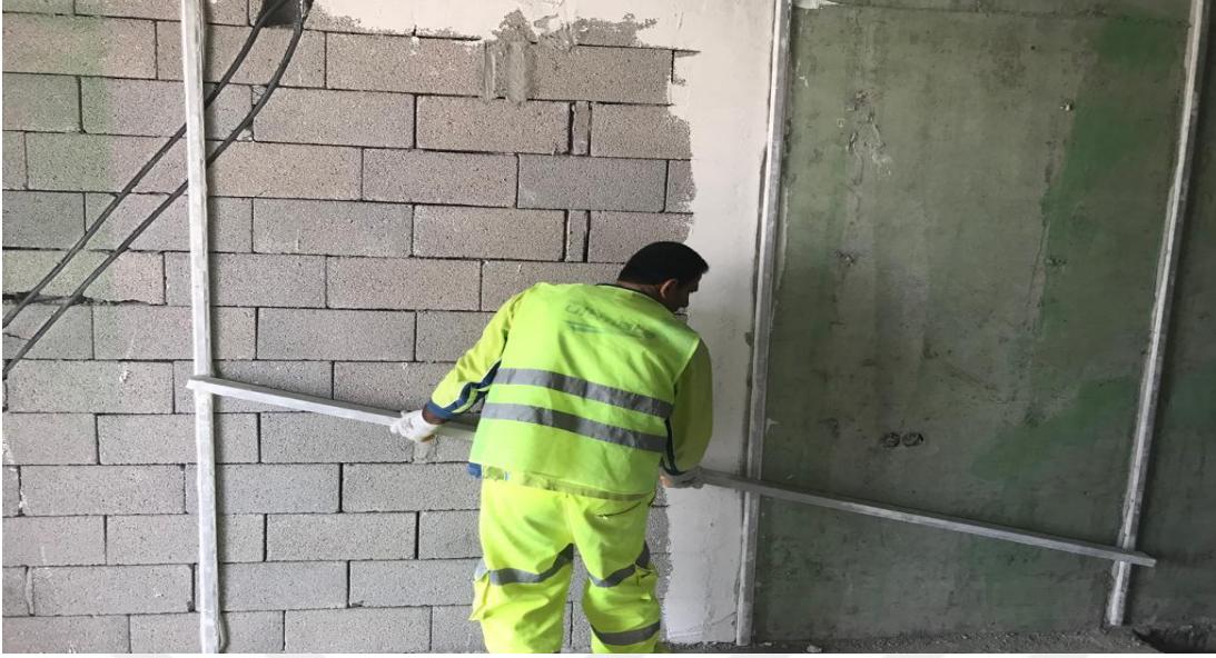
Resim 7.4. Alçı işlemleri öncesi duvar-kolon ve giriş arasındaki uyumsuzluğun giderilmesi için yapılan "ano" çalışması
