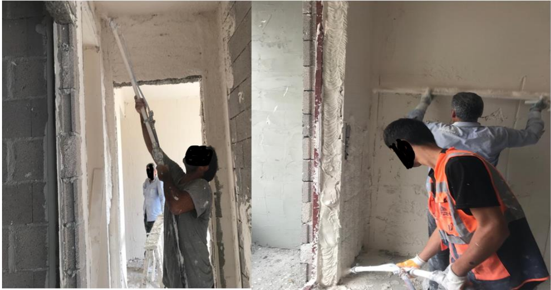
Resim 7.3. Alçı Makinası ile Uygulama Yapan İnşaat İşçileri (Alçı püskürten amele ve master ustası)
