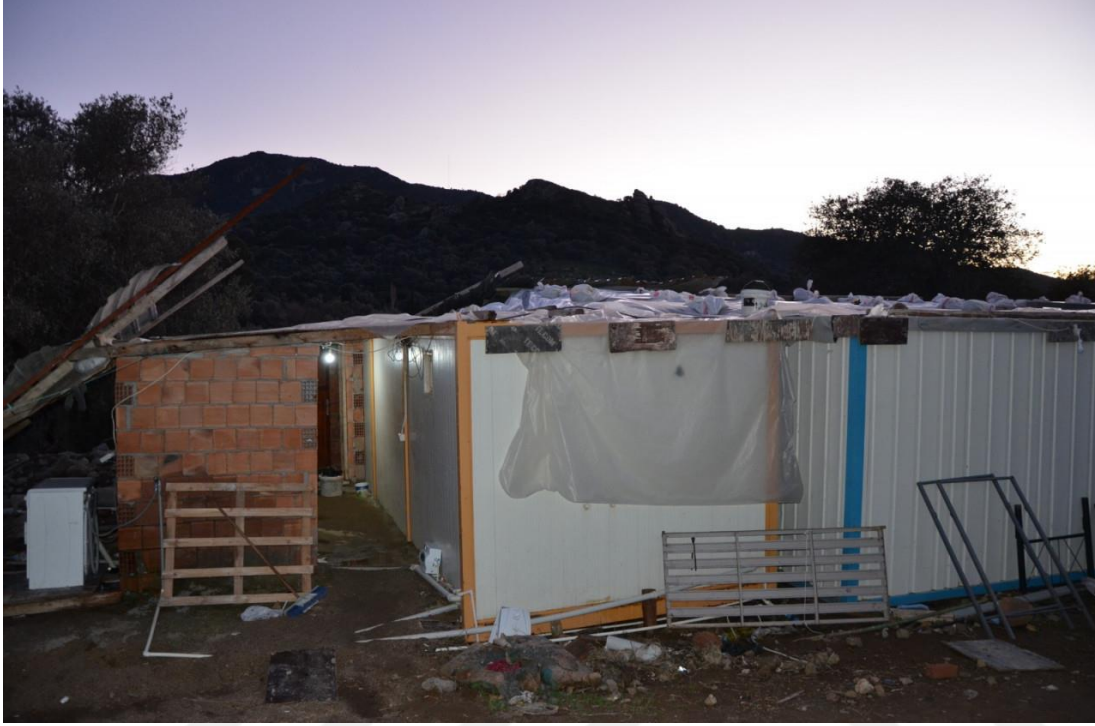
Resim 6.1. İnřaat iřçilerinin mesai sonrası kaldıkları prefabrik yapı
