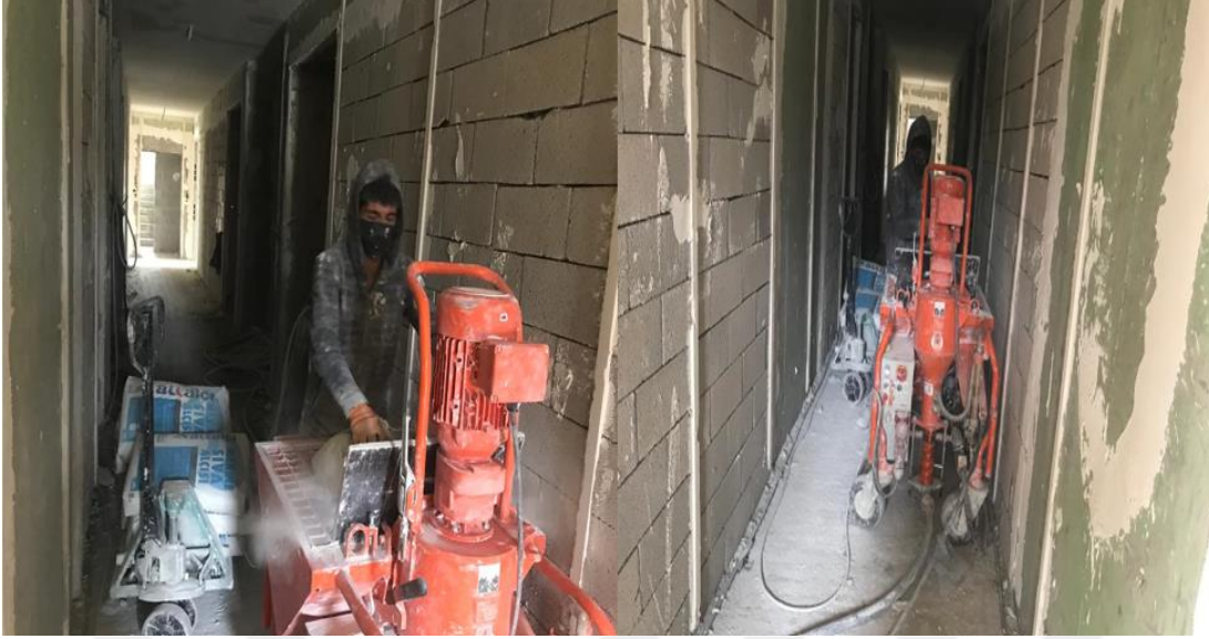
Resim 7.2. Alçı Makinasının İnşaatı Kullanılması- İşçinin Makine Haznesine Alçı Boşaltımı Gerçekleştirilmesi
