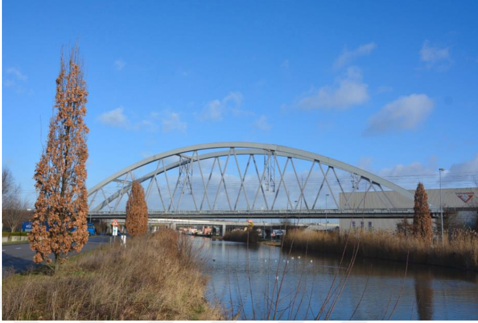
Şekil 3.4.1.4. Yapı sağlığı izlemenin yapıldığı KW51 köprüsü, Belçika (Maes ve ark., 2022)
