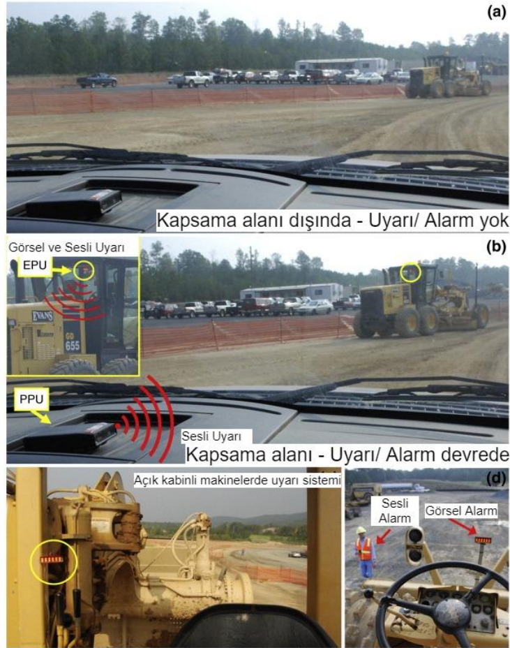
Şekil 3.5.1.11. Tasarlanan Sistemin Şantiye Ortamında Davranışı. EPU (Equipment Protect Unit, Ekipman Koruyucu Ünitesi), PPU (Personal Protect Unit: Personel Koruyucu Ünitesi) (Teizer ve ark., 2010)
