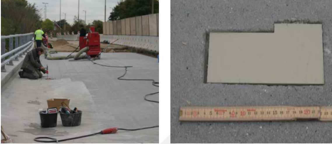
Şekil 2.2.2. Tasarlanan sensörün köprüye yerleştirilmesi (Nielsen & Sørensen, 2010)
