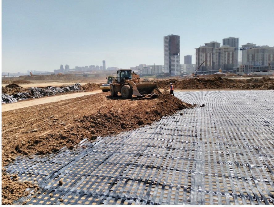
Şekil 2.11. Geosentetikler ile Zemin İyileştirme (Maccaferri, 2024)
