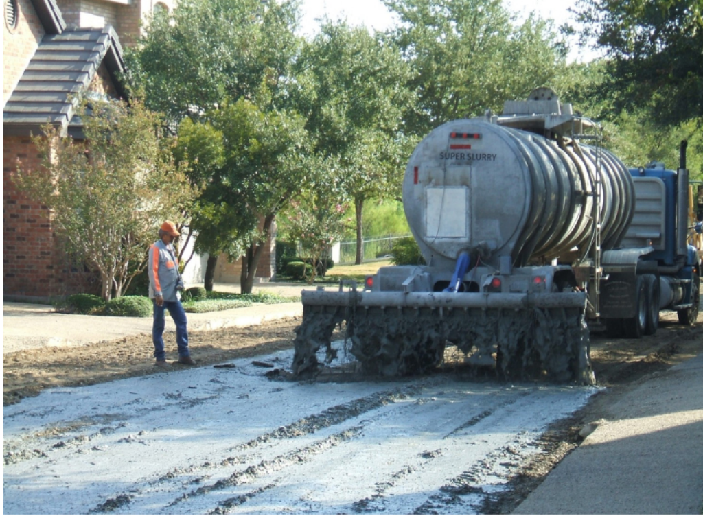
Şekil 2.7. Çimento ile zemin stabilizasyonu (Cement Treated Material, 2024)
