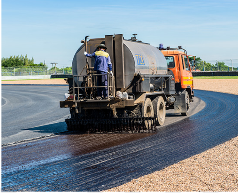
Şekil 2.8. Bitüm ile zemin stabilizasyonu (Tipco Asphalt, 2024)
