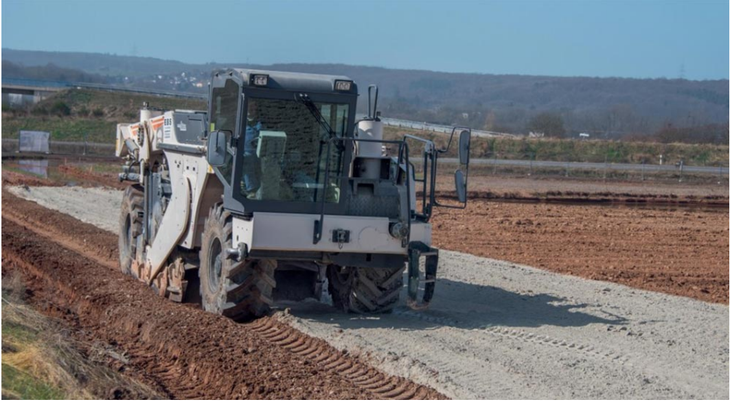
Şekil 2.9. Uçucu külün ile zemin stabilizasyonu (Baxmeyer Construction, 2024)
