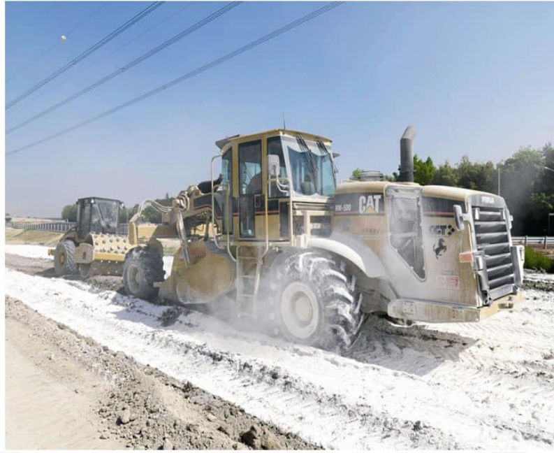
Şekil 2.6. Kireç zemin stabilizasyonunun sahada uygulanması (Engineering Civil, 2024)
