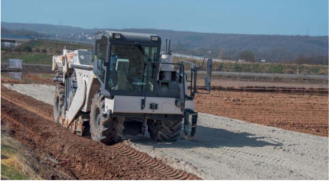
Şekil 2.9. Uçucu külün ile zemin stabilizasyonu (Baxmeyer Construction, 2024)
