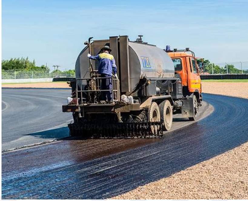
Şekil 2.8. Bitüm ile zemin stabilizasyonu (Tipco Asphalt, 2024)
