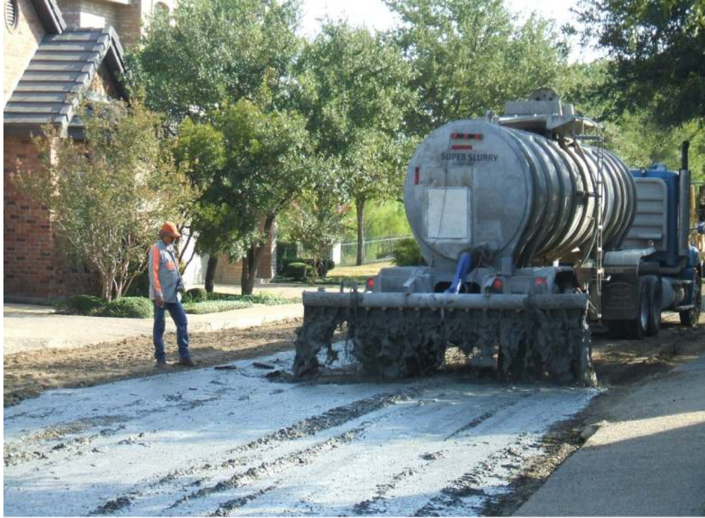
Şekil 2.7. Çimento ile zemin stabilizasyonu (Cement Treated Material, 2024)
