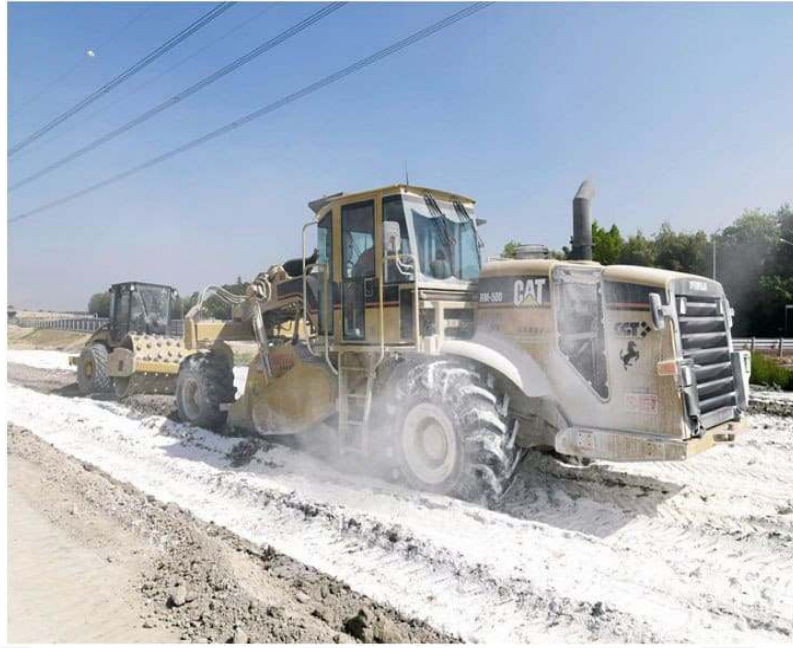
Şekil 2.6. Kireç zemin stabilizasyonunun sahada uygulanması (Engineering Civil, 2024)
