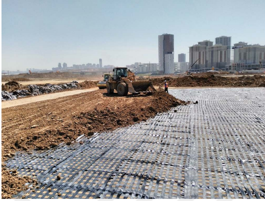
Şekil 2.11. Geosentetikler ile Zemin İyileştirme (Maccaferri, 2024)
