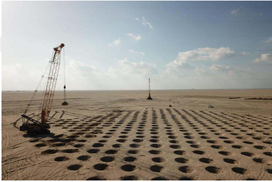
Şekil 2.3. Suudi Arabistan demir yolu yapımında kullanılan kompaksiyon örneği (Keller Middle East, 2024)
