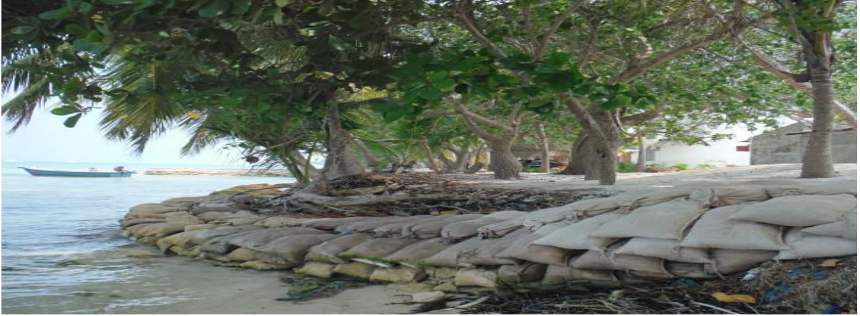
Görsel 4.1 Erozyon ve Su Baskını Azaltmak için Kıyı Şeridine Yerleştirilen Kum Torbaları 580
