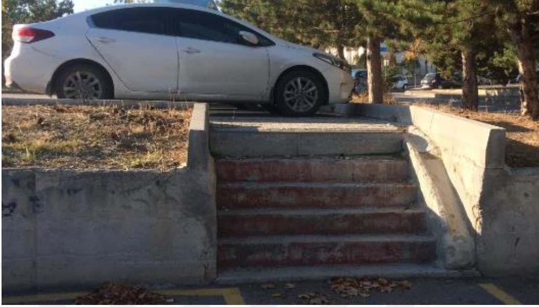
Şekil 4.6. Test alanı #1 içinde yer alan merdiven alanı
