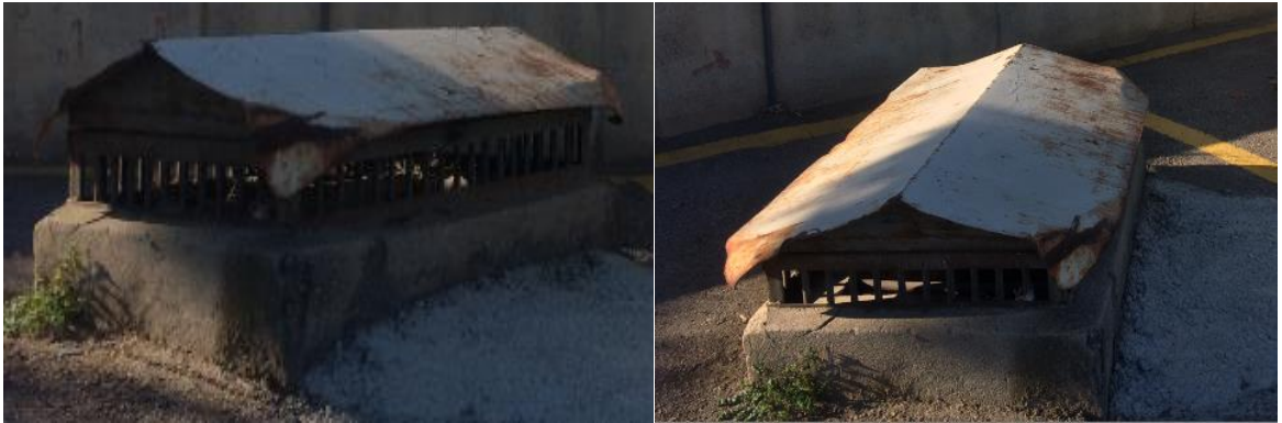
Şekil 4.8. Test alanı #1 içinde yer alan havalandırma bacaları
